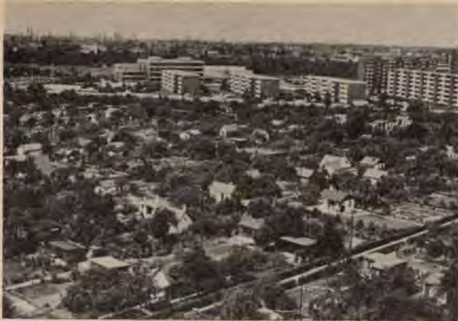
Der Kleingartenpark „Feldmark Hastedt“ aus einem Fenster der angrenzenden Wohnbebauung betrachtet. Auch hier kommt die Kleingartenplanung als Element des Städtebaues gut zum Tragen.
