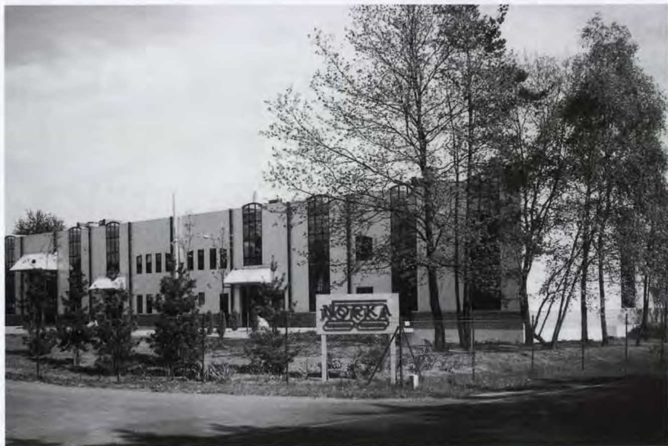
NORKA – In Hülsen auf dem Betriebsgelände der ehemaligen Kaliwerke
