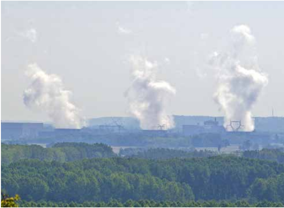
Als das Bild entstand, dampften die Kühltürme noch. Mitte Mai jedoch waren alle vier Reaktoren des AKW Chinon an der Loire bis auf Weiteres außer Betrieb
