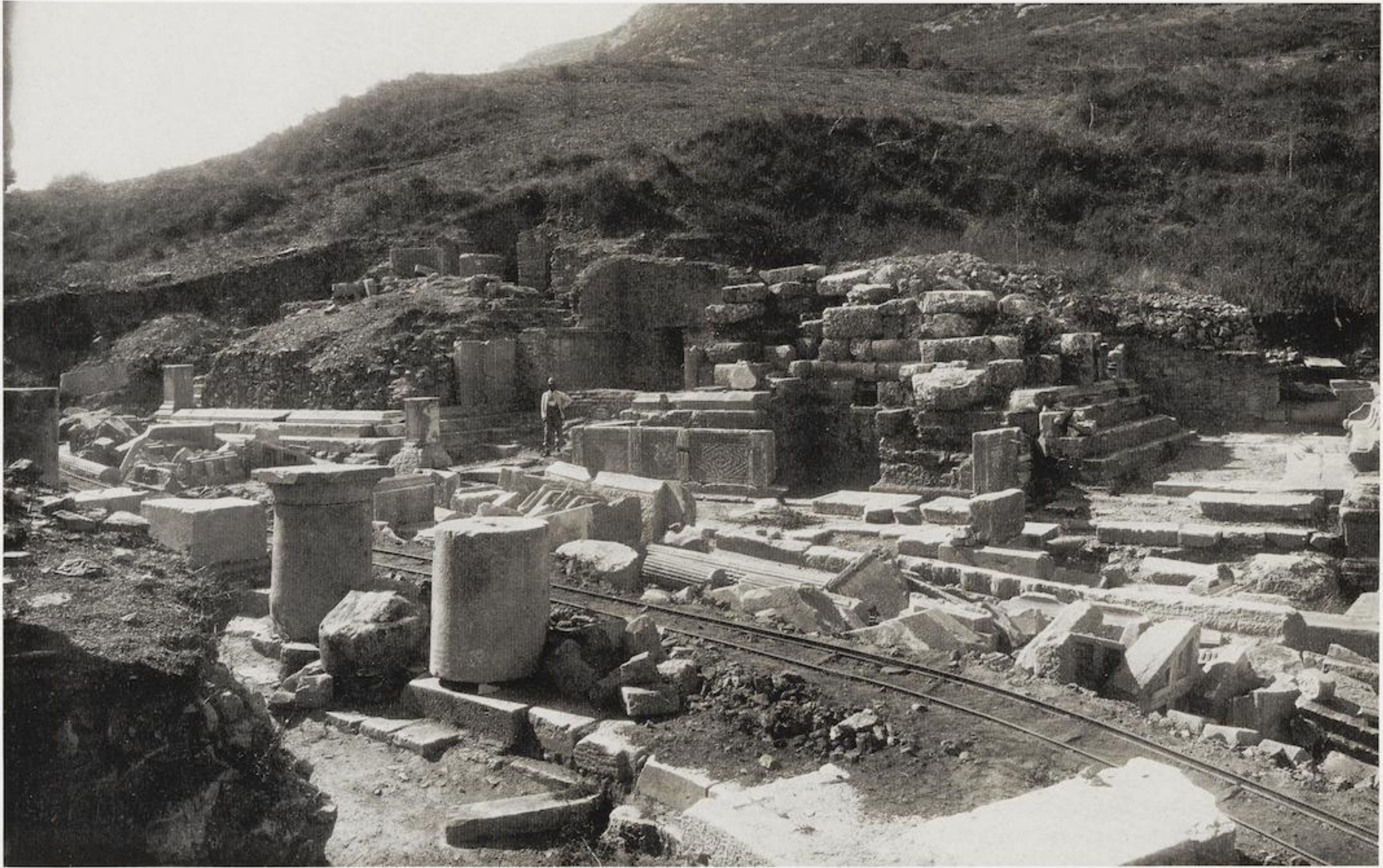
1: Hanghäuser vor der Ausgrabung.
