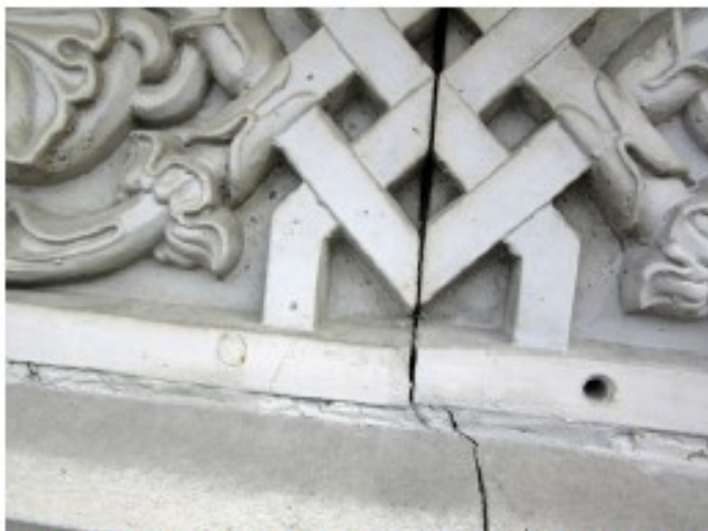
Der Riss läuft in die Fuge des Zierelementes und setzt sich in der Fuge des Bankgurtes fort.
