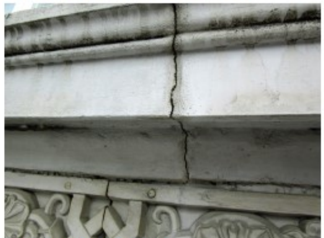
Der Riss läuft in die Fuge des Zierelementes und setzt sich in der Fuge des Bankgurtes fort.
