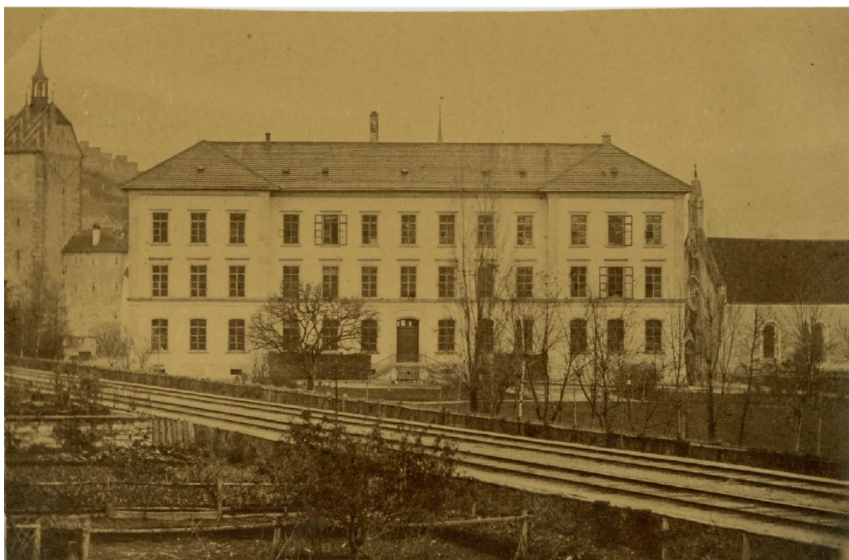
Ansicht Südfassade ca. 1887, Quelle aargauische Denkmalpflege
