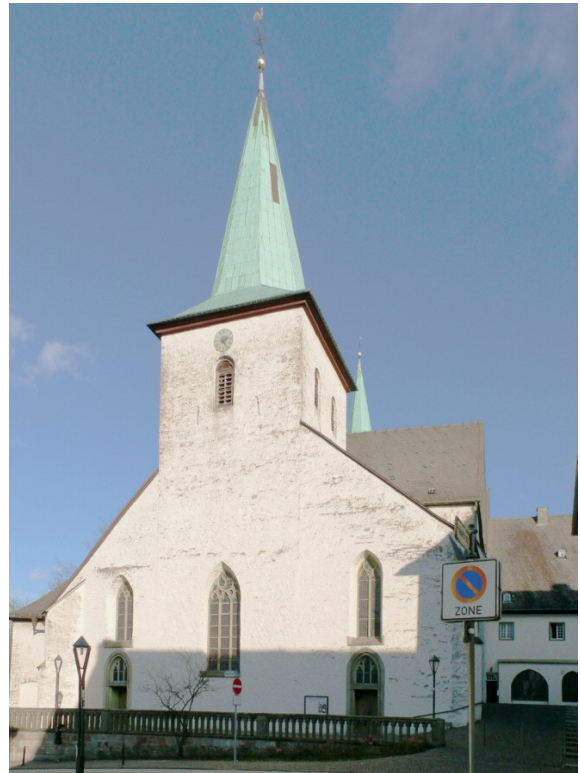
Bild 3. Westansicht der Wedinghausener Propsteikirche.
