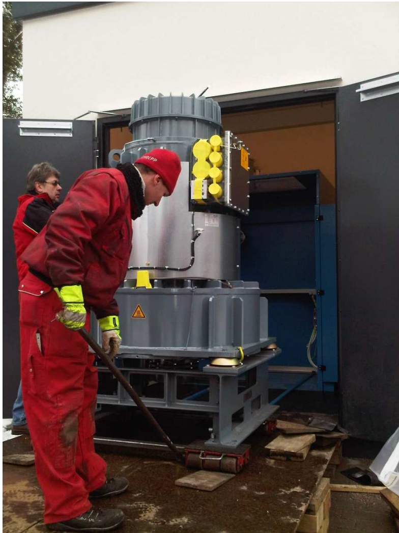
Bild 12: Einbringung Energiespeicher (Foto: Flösch)
