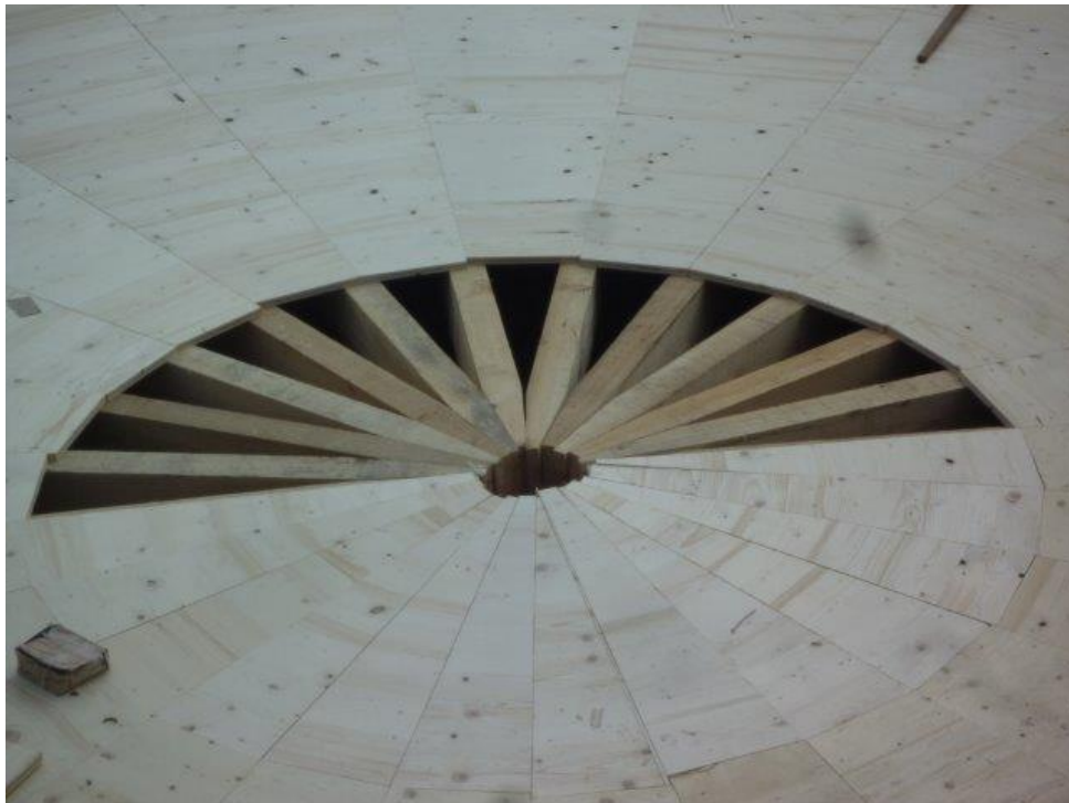
Abdeckung einer offenen Güllegrube mit einer Holzkonstruktion
