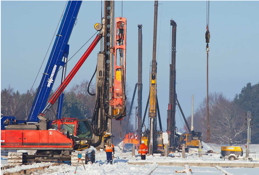
Abb. 5: Herstellung der Fertigbetonrammpfähle als vertikale Tragelemente – Quelle: Centrum Pfähle GmbH
