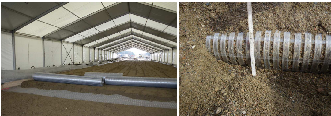
Abb. 6a und Abb. 6b: Herstellung des geogitterbewehrten Bodenkörpers (Abb. 6a) einschl. Ausbildung der Umschlagsbereiche der Geogitter (Abb. 6b) – Quelle: BAUGRUND DRESDEN Ingenieurgesellschaft mbH
