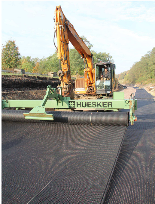
Abb. 7: Einbau der extrem anisotropen Geogitter parallel zur Fahrwegachse mit einer Verlege-traverse. Quelle: GEOscope GmbH & Co. KG
