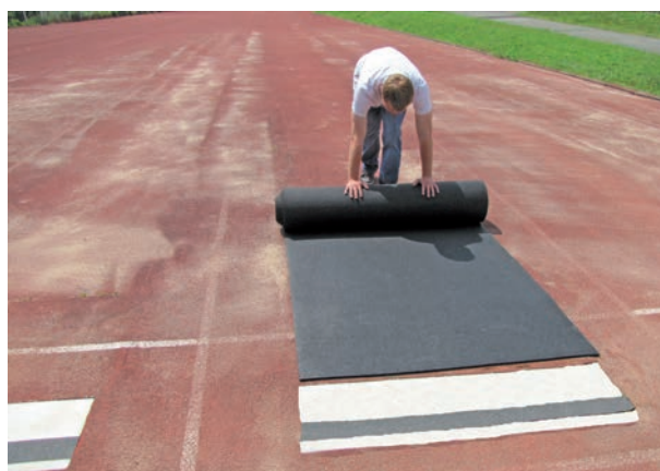
Die Regupol® Anlaufbahn lässt sich in kurzer Zeit ausrollen und nötigenfalls auch wieder entfernen. Auf gebundenen Tragschichten kann sie dauerhaft verklebt werden.
