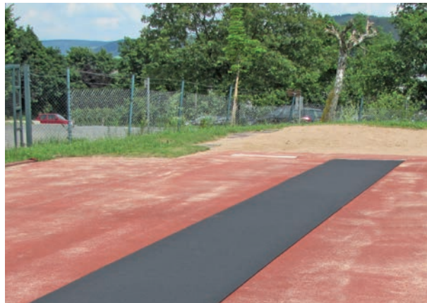
Die Regupol® Anlaufbahn bietet hohen Laufkomfort auch auf alten Untergründen.
