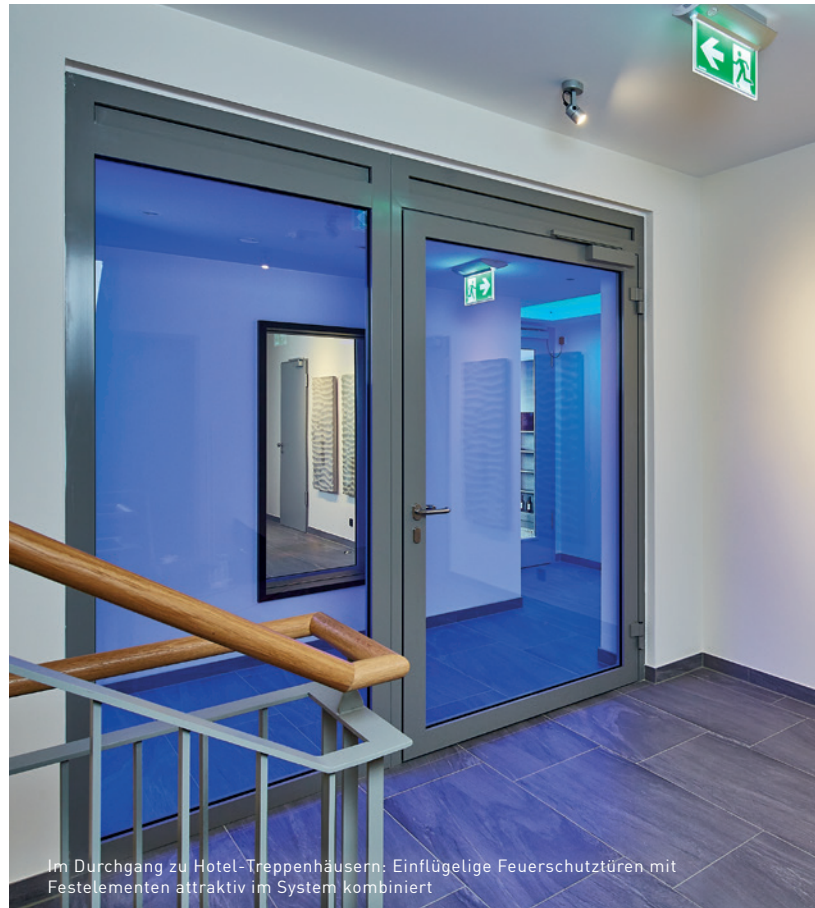
Ganzglaswände in der Ausführung T30 (Ei, 30) lauch mit integrierter Tür von Novoferm für transparente Raumabschlüsse für offene Raumgestaltung
