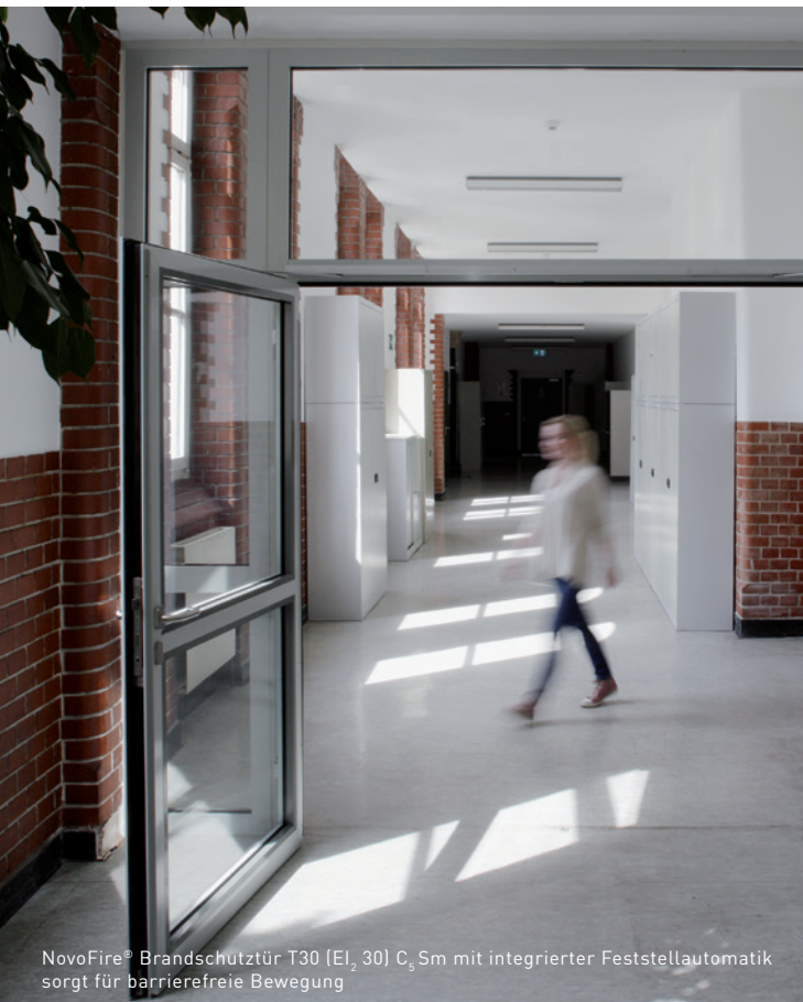
Bis zu 5 m hohe Brandschutzverglasung
