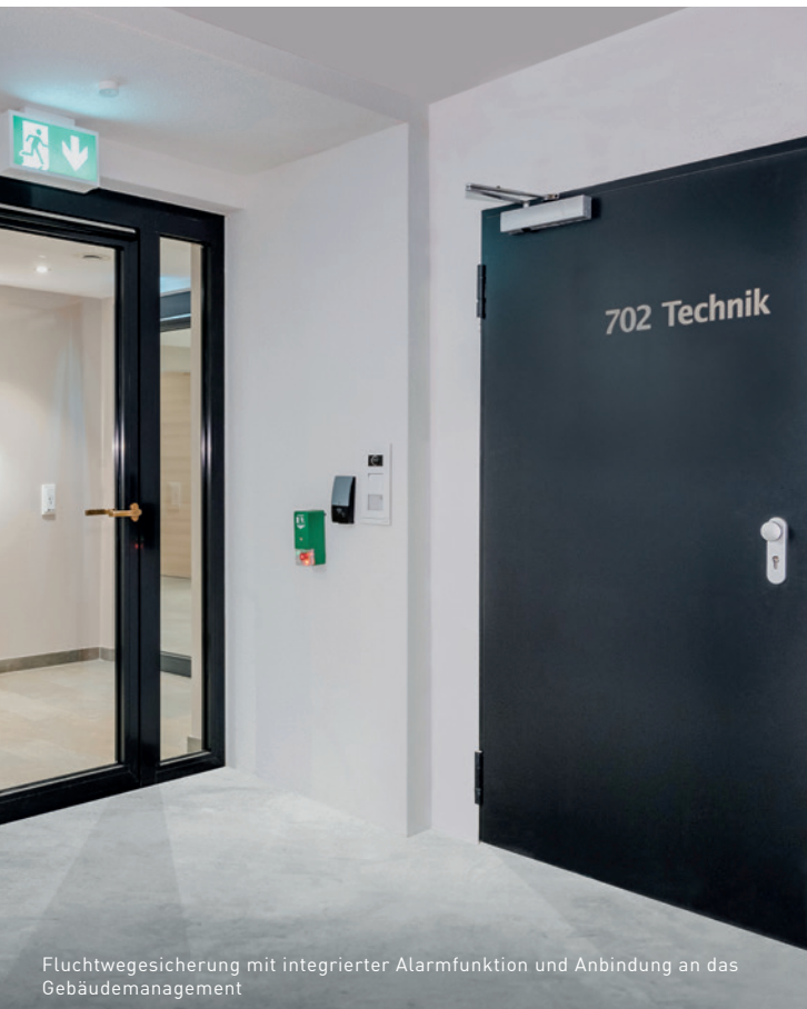
Rohrrahmentüren NovoFire® T30 (EI30) RS mit Seitenteil in F30-Verglasung, in sehr robuster Ausführung mit drei Türbändern für den Alltagsbetrieb innerhalb des Verwaltungstrakts
