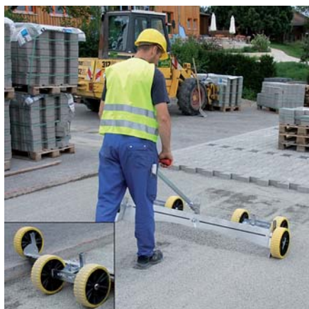
LF-125/215. links unten: Rad-Höhenverstellung
