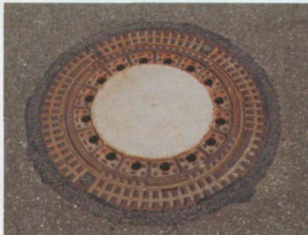
perfekt regulierter Schacht mit selbstnivellierender einwalzbarer Abdeckung
