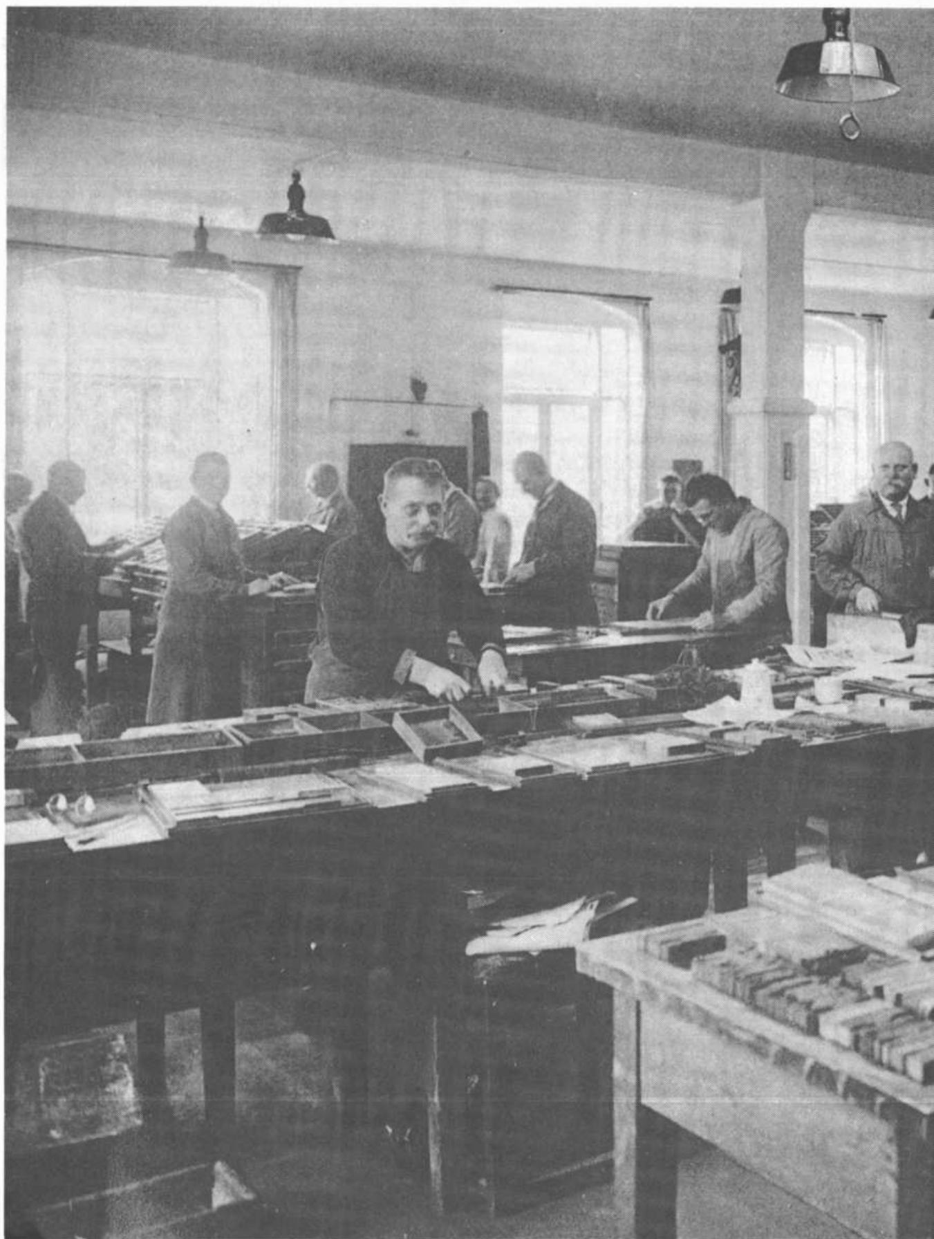
Im Saal der Setzerei: „Inzwischen stellt der Metteur im Beisein des betreffenden Redakteurs die Seite zusammen, nachdem die Überschriften mit der Hand gesetzt worden sind.“ Die Satzherstellung und die Montage der einzelnen Seiten geschieht in einem großen Saal. Im Hintergrund ist wieder die Handsetzerei zu
