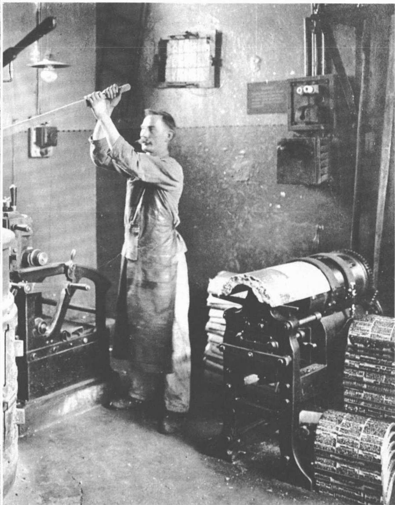
Lederschürze schützt ihn vor flüssigen Metallegierungen aus Blei (80%), Antimon und Zinn. Die entweichenden Dämpfe sind sehr ungesund. Im Mittelpunkt des Bildes ist der Schmelzkessel erkennbar, ganz rechts sind die fertig geprägten Stereotypen zu sehen. Dazwischen steht der Fräsapparat, mit dem die Stereotypen abgeputzt und angebohrt werden.
