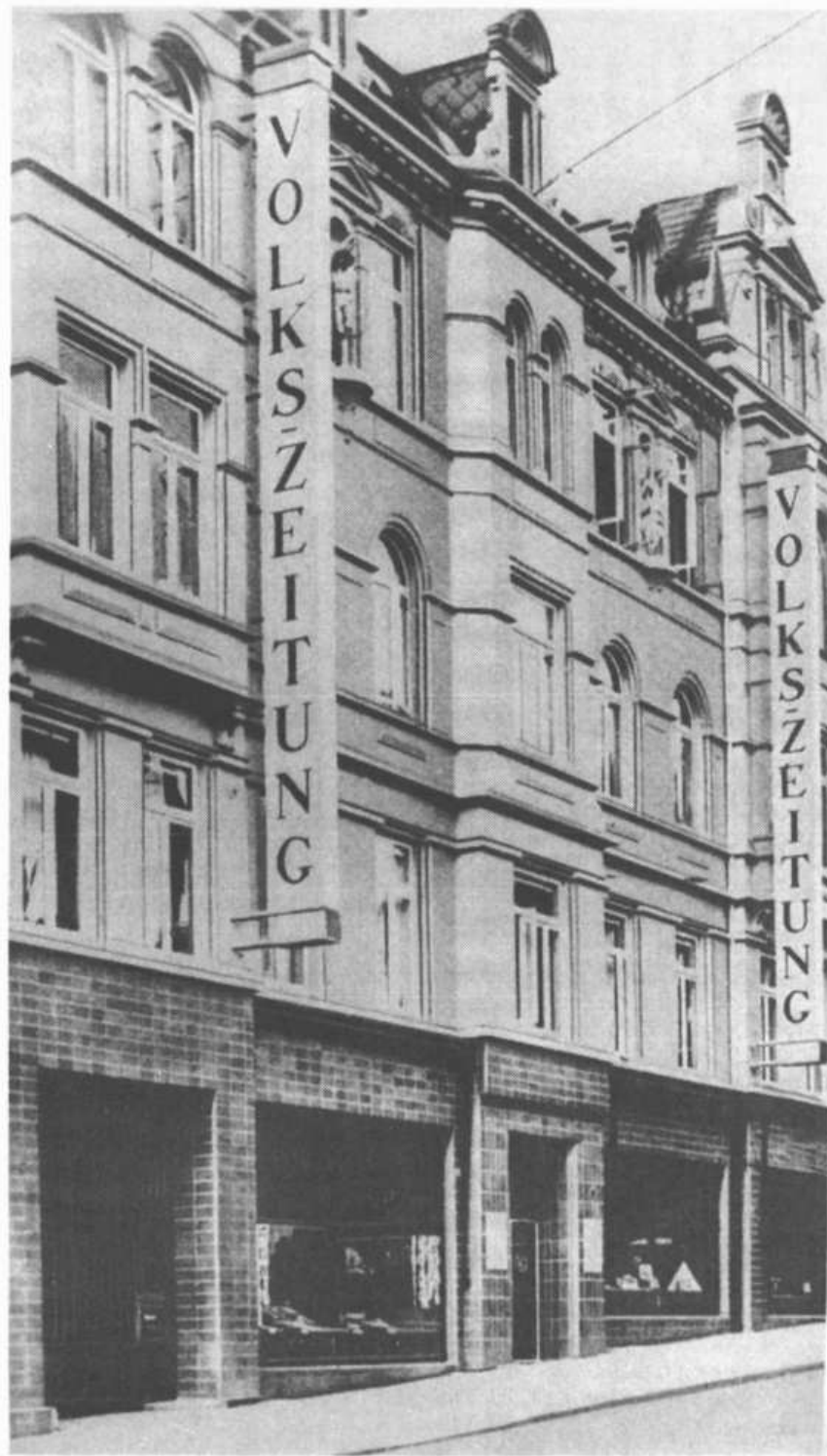
Gebäude der Volkszeitung
