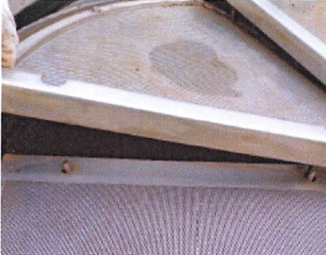
Abb. 6: Siebabdeckung auflegen (Flächen müssen substratfrei sein)
