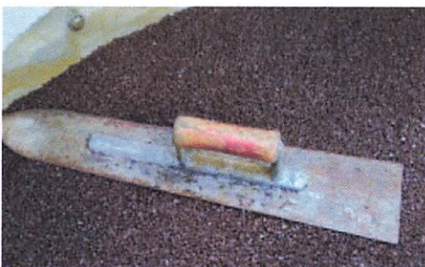
Abb. 4: Abziehen des Substrats
