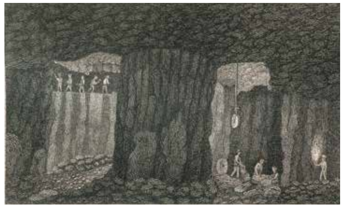
Abb. 17: Mühlsteinbruch untertage. Die Arbeiter arbeiten auf der Glockenbahn unter dem Siegel (links), die Mühlsteine werden im Licht des Schachtes ausgehauen (rechts). Stahlstich nach einer Zeichnung des Herrn Generals van der Wyck. (Leonhard 1844, Tafel LXXXII, Fig. 2, bez.: „Gewinnung der Rheinischen Mühlsteine bei Niedermendig“)
