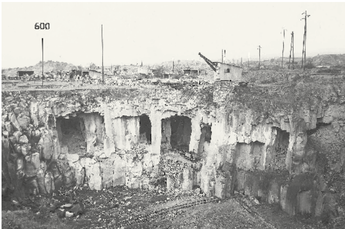
Abb. 10: Grube Adorf in den 1930er Jahren: Kleinteiliger Abbau des Systems A ist angeschnitten. (© Foto: Eifelarchiv Abt. Geschichts- & Altertumsverein für Mayen und Umgebung e.V., o. Nr.)
