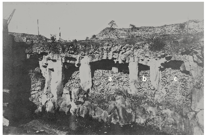
Abb. 5: Steingrube des Betriebs Wilhelm Goebbels in den 1920er Jahren: An der Nordwestseite der Grube sind durch den modernen Betrieb die alten Untertagebaue (z.B. Kammern a-c) im System H angeschnitten. Sie sind bis unter die Siegel mit Schutt aufgefüllt. Über dem Altbergbau lagern die Rötschen. (© Foto: Eifelarchiv Abt. Geschichts- & Altertumsverein für Mayen und Umgebung e.V., o. Nr.)
