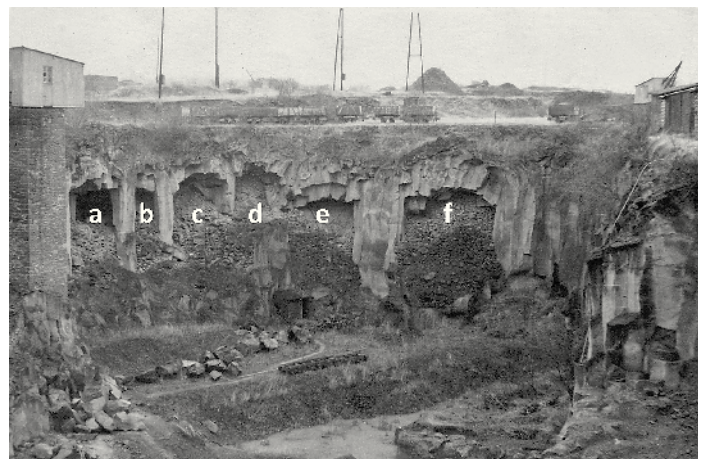
Abb. 6: Steingrube des Betriebs Wilhelm Goebbels in den 1930er Jahren: An der Nordseite der Grube sind durch den modernen Betrieb die alten Untertagebaue (Kammer a-f) angeschnitten; der größte Teil der über tage auflagernden Rötschen ist bereits abgetragen. (© Foto: Eifelarchiv Abt. Geschichts- & Altertumsverein für Mayen und Umgebung e.V., o. Nr.)
