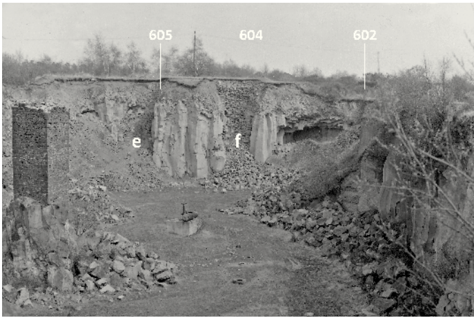
Abb. 8: Steingrube des Betriebs Wilhelm Goebbels um 1970: An der Nordostseite der Grube sind durch den modernen Betrieb die alten Untertagebaue (Kammern e, f; Schächte 602, 604 und 605) angeschnitten; der Basaltabbau ist eingestellt. (© Foto: Eifelarchiv Abt. Geschichts- & Altertumsverein für Mayen und Umgebung e.V., o. Nr.)
