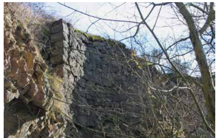
Abb. 13: Mauerreste des Schachts 602 über dem Siegel des Lavastroms. Die senkrechte Mauerkante ist der Rest einer Einfahrtsöffnung. (© Foto: Joern Kling, 2006)
