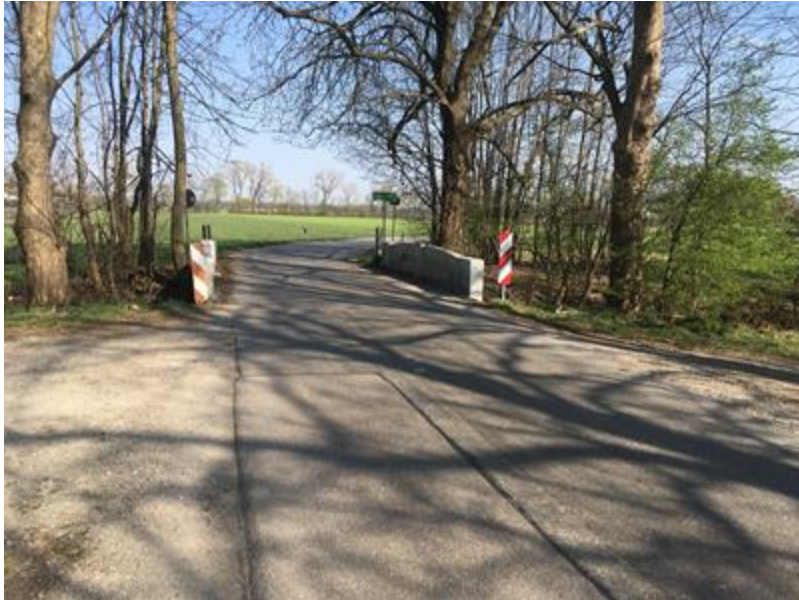
Bild: bestehende Brückensituation – Betrachtung in Richtung Karlsfeld
