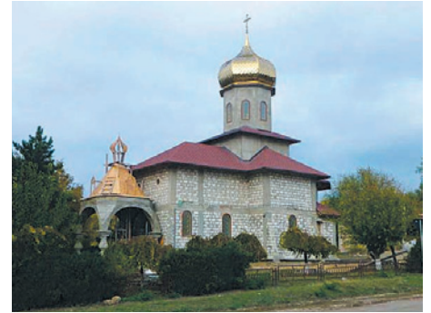
Die orthodoxe Kirche ist im Robbau fertig. Bunte Fenstergläser vermitteln im Innern einen angenehmen Eindruck.
