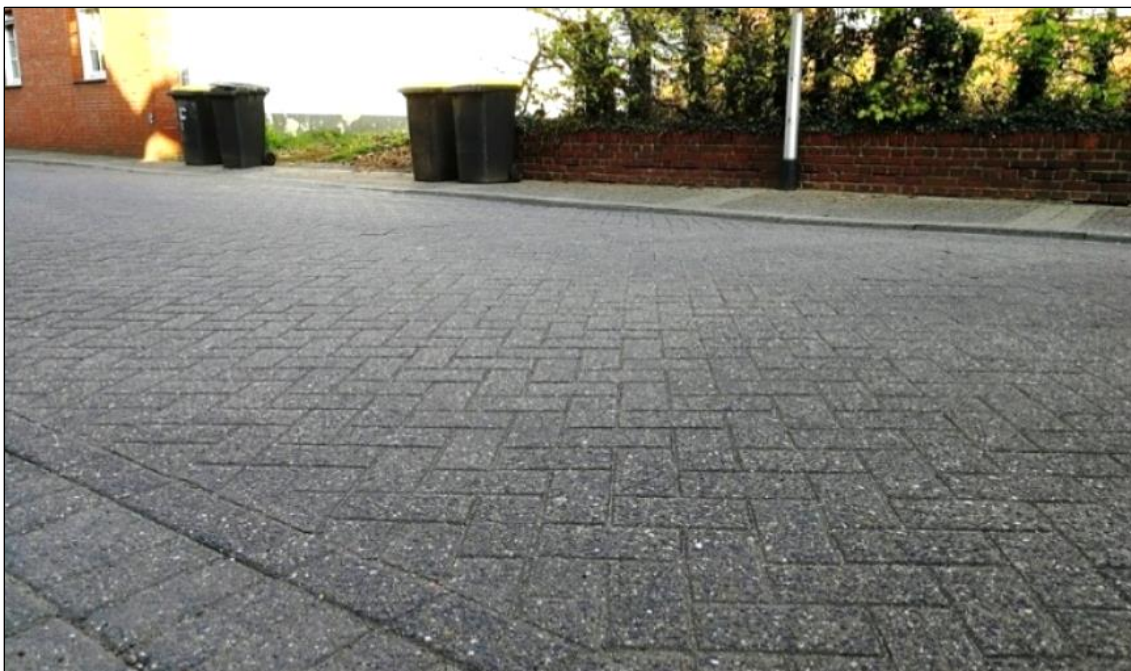
Bild 40: Tadellose Pflasterdecke aus Rechtecksteinen im Fischgrätverband in der Ortsdurchfahrt von Wassenberg (Nähe Heinsberg) nach rd. 35jähriger Liegedauer (Foto: SLG)
