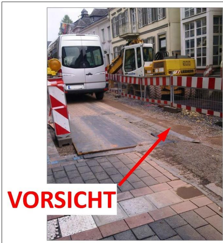
Bild 7: Durch vielfache Befahrung abgedichtete Tragschicht im Zuge einer innerörtlichen Baumaßnahme (Foto: SLG)
