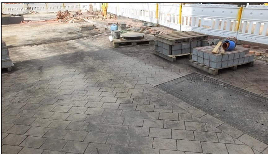
Bild 19: Grundsätzlich ist es bautechnisch von Vorteil, wenn Fugenmaterial längere Zeit auf dem Pflaster verbleibt, dabei darf es jedoch nicht zu dauerhaften Verfärbungen der Pflastersteine kommen (Foto: SLG)
