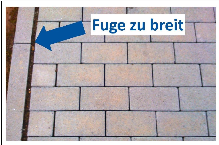
Bild 24: Die Fugen im Bereich von Anschlüssen gehören zur Pflasterdecke (Foto: SLG)
