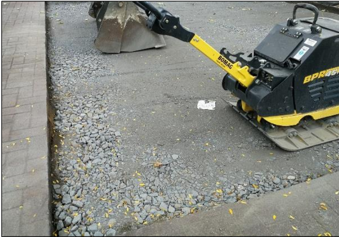
Bild 8: Bei der Herstellung der ToB ist darauf zu achten, dass es nicht zu Entmischungen kommt, die eine ungleichmäßige Oberflächenbeschaffenheit zur Folge haben (Foto: SLG)
