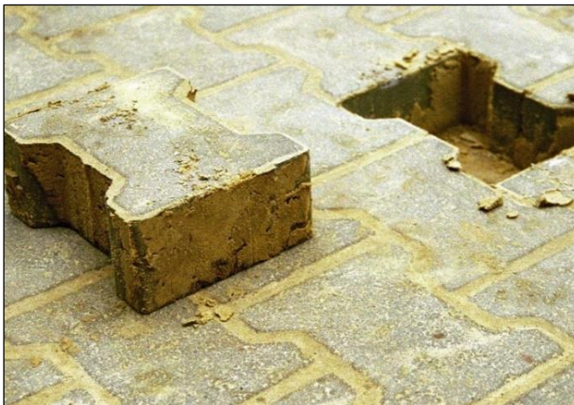
Bild 37: Vollständige Fugenfüllung nach maschinelltem Einschlämmen (Foto: SLG)
