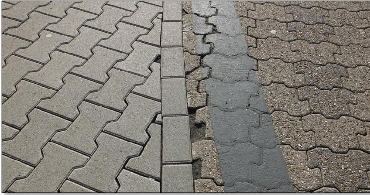
Bild 34: In Anschlussbereichen mit Verbundsteinen sind Bereiche mit erhöhtem Erhaltungsaufwand nicht immer zu vermeiden (Foto: SLG)
