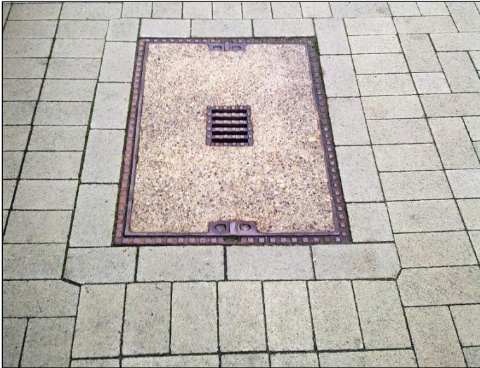
Bild 32: Fachlich und handwerklich gelungener Anschluss einer Pflasterdecke aus Rechtecksteinen an einen Kabelschacht mit Hilfe von Passteinen (Foto: SLG)
