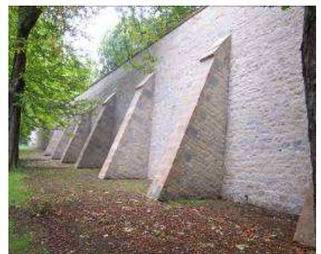
mit Erdnägel gesicherter Bereich
