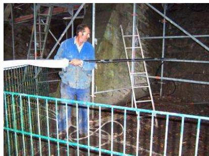
Einbau bestrumpfter Erdanker
