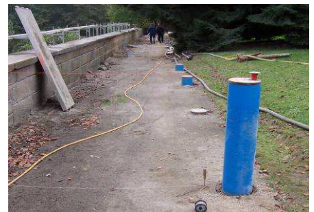
Vertikaldrainagen: Filterrohre vor Absenken
