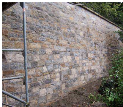
im Trockenspritzverfahren nachverfugt
