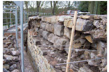
Teilerneuerung: Nadeln zur Schalenanbindung
