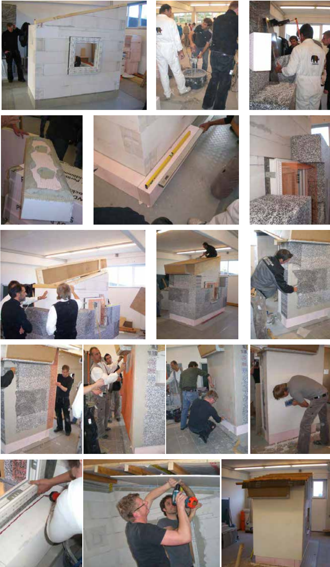
Praktische Arbeit Gruppe 2: Einschaliges Mauerwerk mit Wärmedämmverbundsystem Fotos: Jan Freitag und Dirk Osterloh
