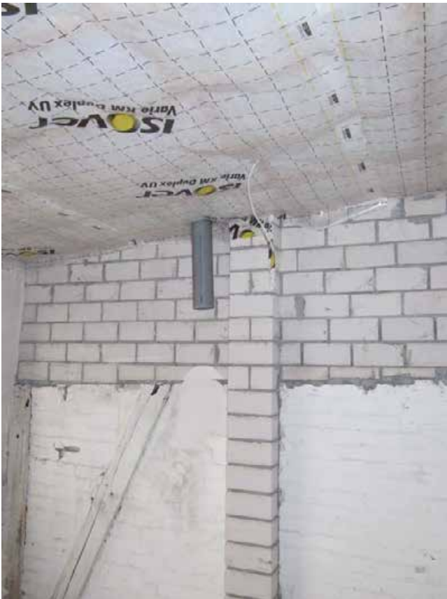
[Bild 17 & 18] Innenausbau: Kabel- und Leitungsdurchführung durch die luftdichte Ebene
