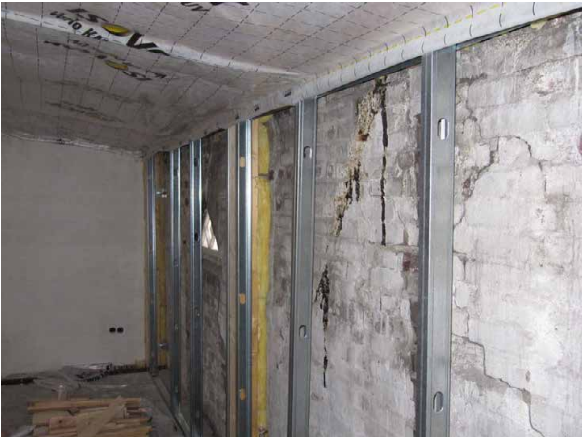
[Bild 13 & 14] „Blanke“ Straßenfassade im Klinkermauerwerk, mit Teilen der Vorwandinstallationsebene für die Innenwanddämmung
