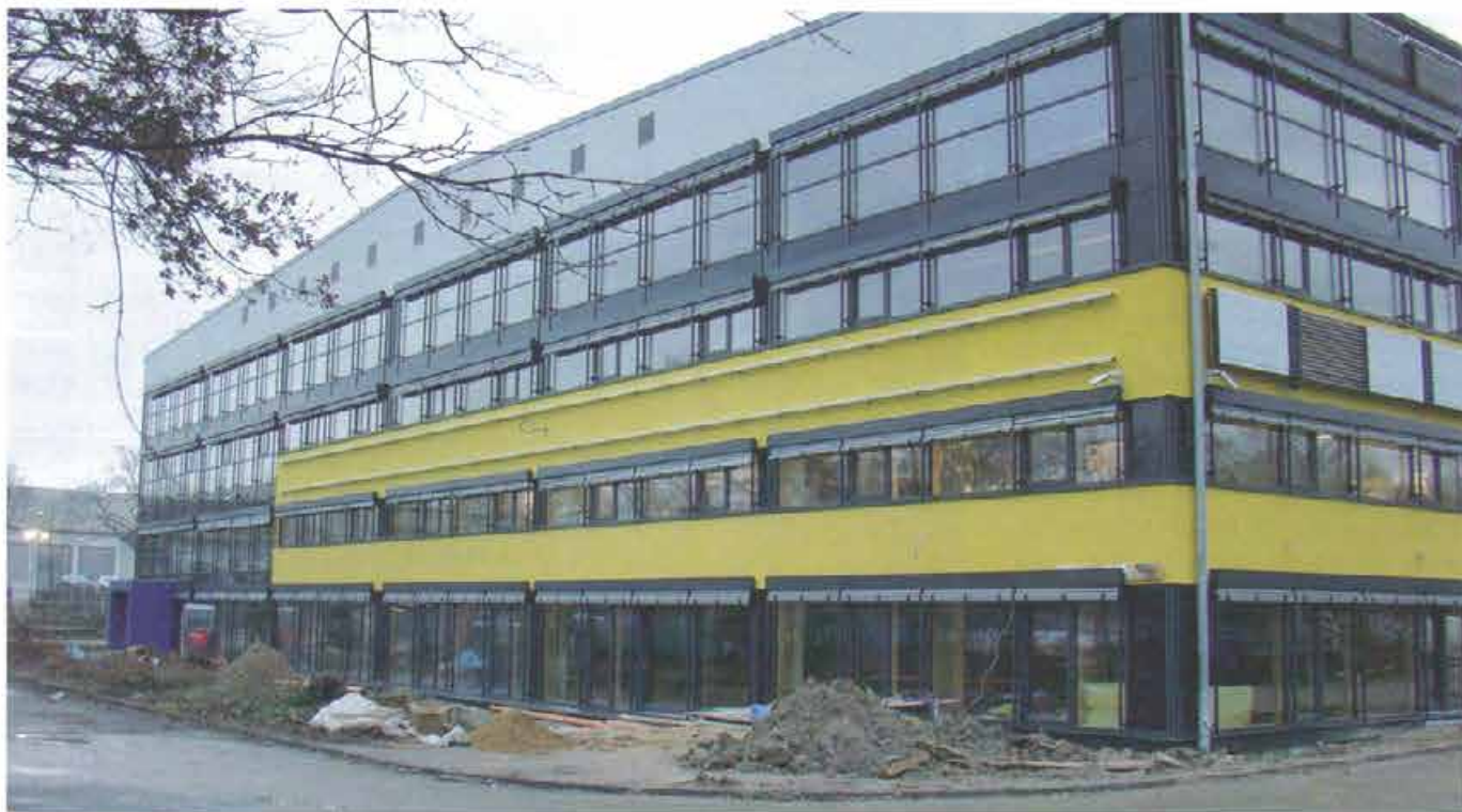
Aus Neugier, nicht wegen Mängelrügen wurde die Ebenheit der Fassade nachgemessen. Auf rund 90 m Länge und rund 12 m Höhe ergaben sich maximale Abweichungen von der Ebenheit von + 5 mm und - 3 mm. Das ist kaum zu unterbieten! Chapeau würde der Franzose sagen.
