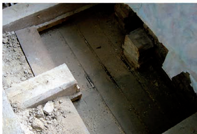
Bild 4. Stoffprobenentnahme Deckenbalken: Außenputz (oben links), Abstützung des Deckenbalkens (oben rechts) und Deckenbalken am Kopf getrennt (unten)
