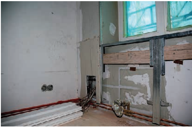
Bild 9. Innendämmung während der Bauausführung Fig. 9. Internal insulation during construction
