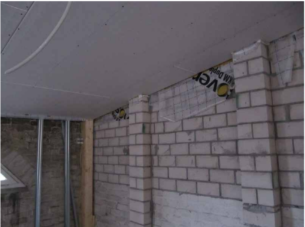
[Bild 16] Anschluss Innenwanddämmung an Dach ( Das ursprüngliche Pultdach wurde zu einem leicht angeschrägtem Pulldach aufgemauert )
