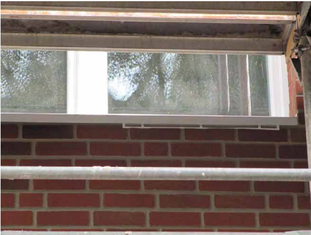
[6 ]& [7]Lüftungsgitter unterhalb der Fensterbank, Einbauelement unter der Riemchen Verblendung
