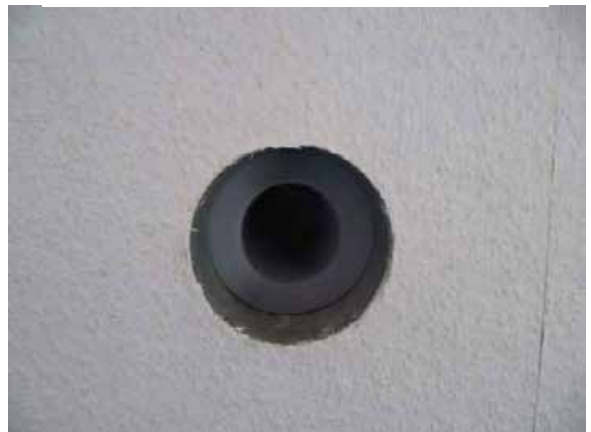
[4] & [5] Kernbohrung für den Aussenwand Lufteinlass
