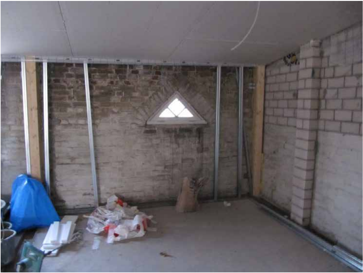
[Bild 13 & 14] „Blanke“ Straßenfassade im Klinkermauerwerk, mit Teilen der Vorwandinstallationsebene für die Innenwanddämmung
