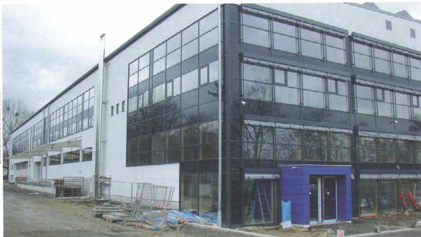
Eine Holzkonstruktion in Passivhaus-Standard bildet die neue Umhüllung eines alten Industriebaus.
