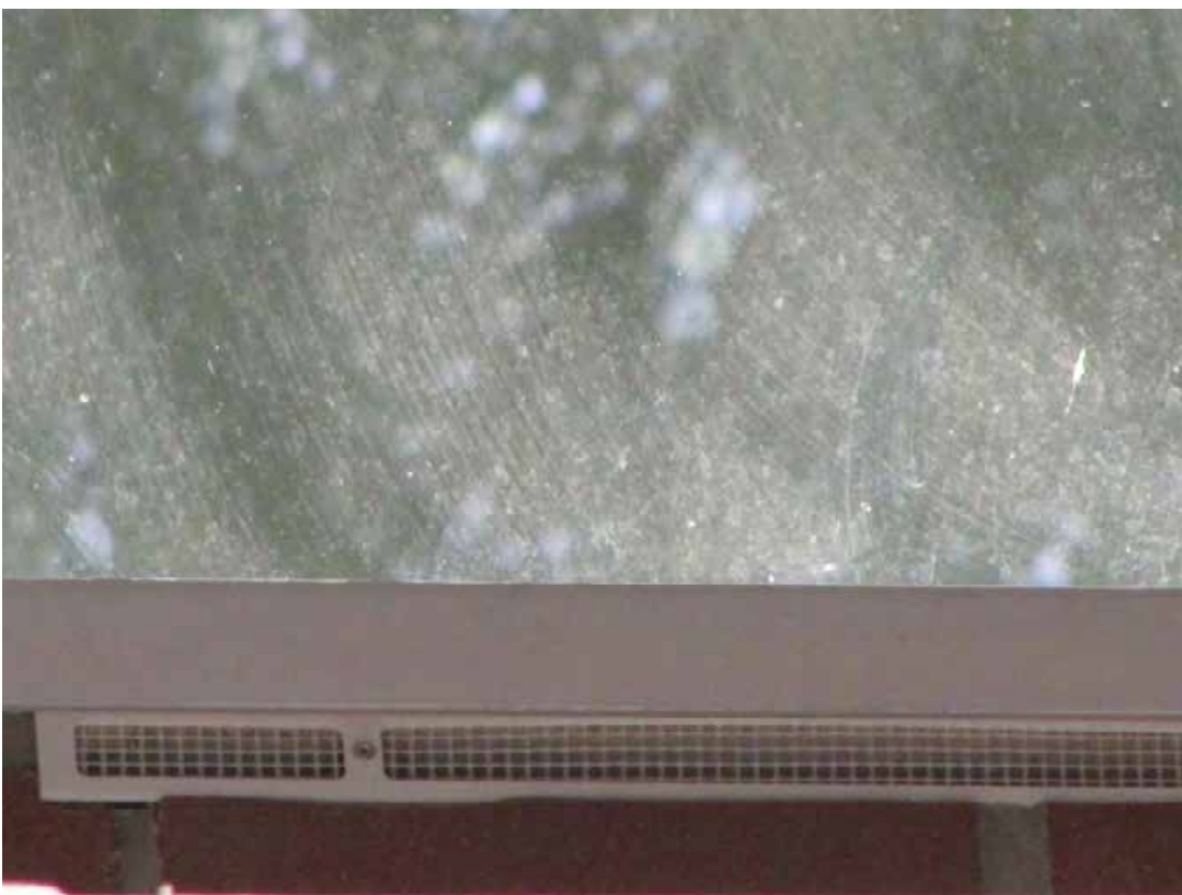
[6 ]& [7]Lüftungsgitter unterhalb der Fensterbank, Einbauelement unter der Riemchen Verblendung
