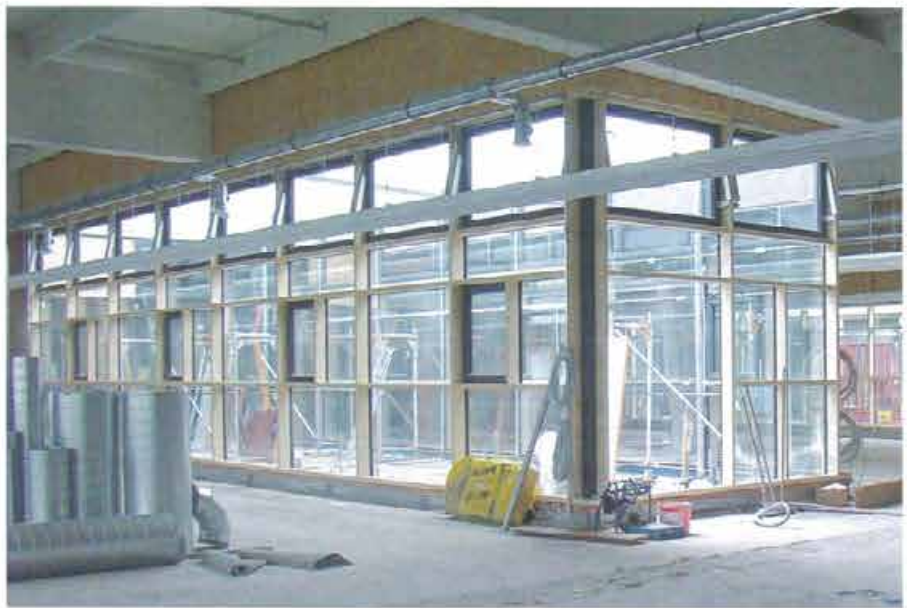
In den vier Lichthöfen innerhalb des Gebäudes gehen die Pfosten durch. Mit Knapp-Ricon-Verbindern wurden die vorgefertigten „Leitern“ über Zwischenriegel zu dem „Turm“ gefügt. Verglasungen und geschlossene Felder wurden dann Zug um Zug eingebaut.
