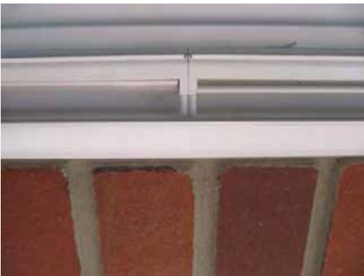
[3] Detail der Lüftungsclappe (versch. Stellungen, links geschlossen, rechts offen)
