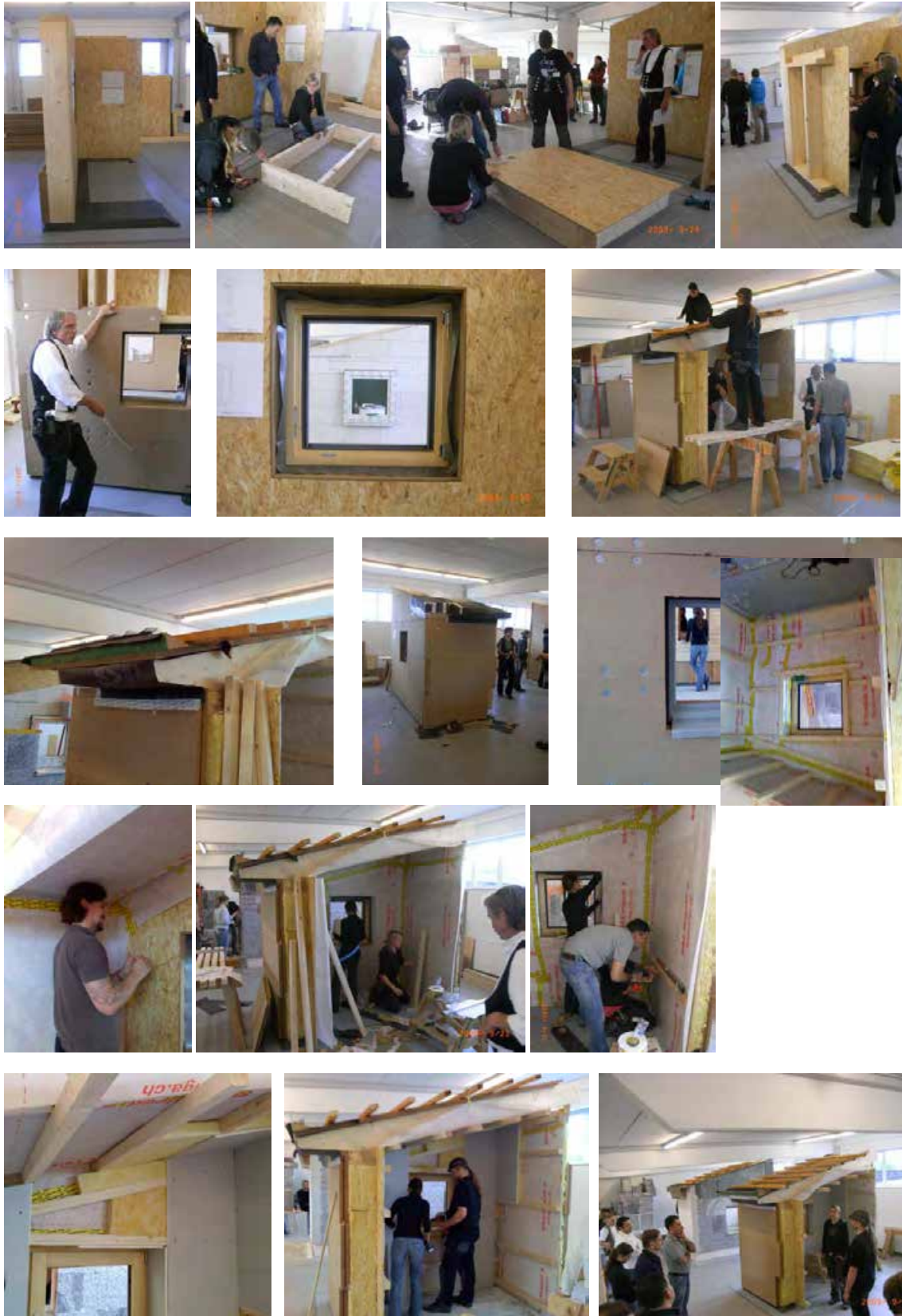
Praktische Arbeit Gruppe 3: Holzrahmenbau KVH mit WDVS Fotos: Marcus Bornemann und Behnen Uerek
