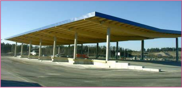
Überdachter Containerstellplatz Roofed container storage area
