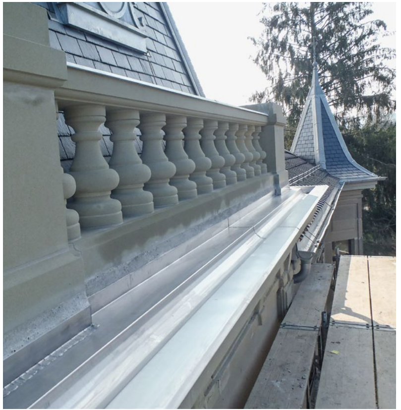
Neu erstellte Sandstein-Balustrade mit Gesimsrinne aus mattiertem Edelstahl der Marke Ugitop
