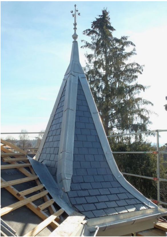
Der Spitzturm wurde mit Titanzink-Kehlen, Gratblechen und einer Turmspitze ausgestattet
