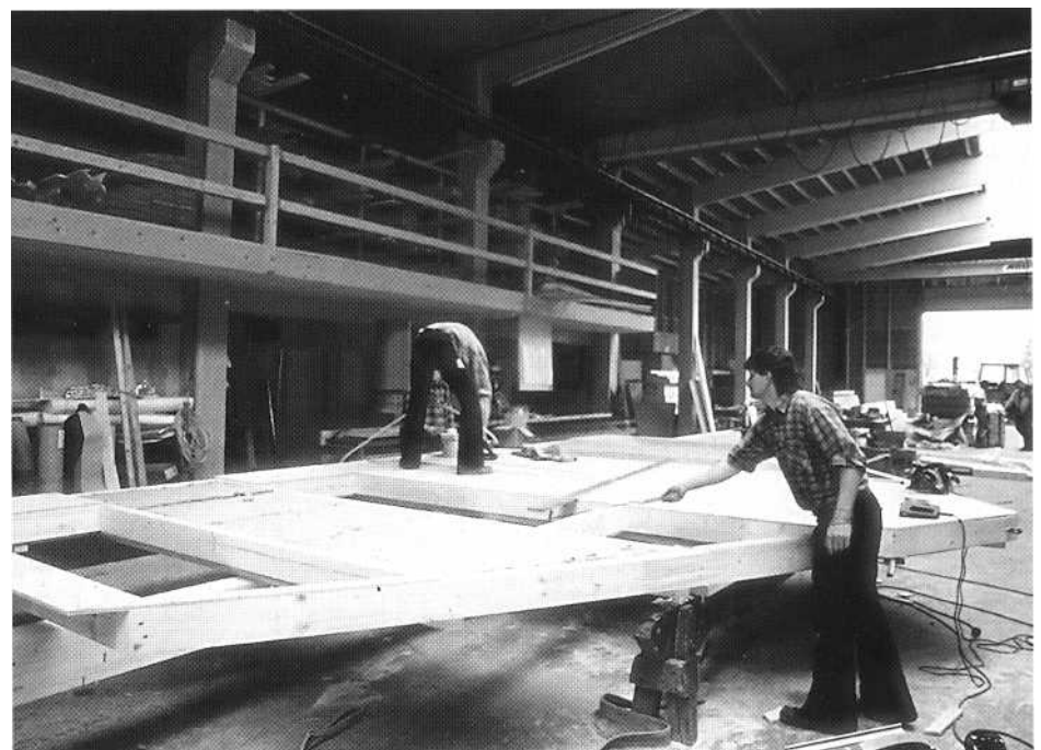
Bild 2.17 Die Vorfertigung der großformatigen Holzrahmenbauelemente erfordert durchgehende Hallenflächen (Werkfoto: Glunz AG)
