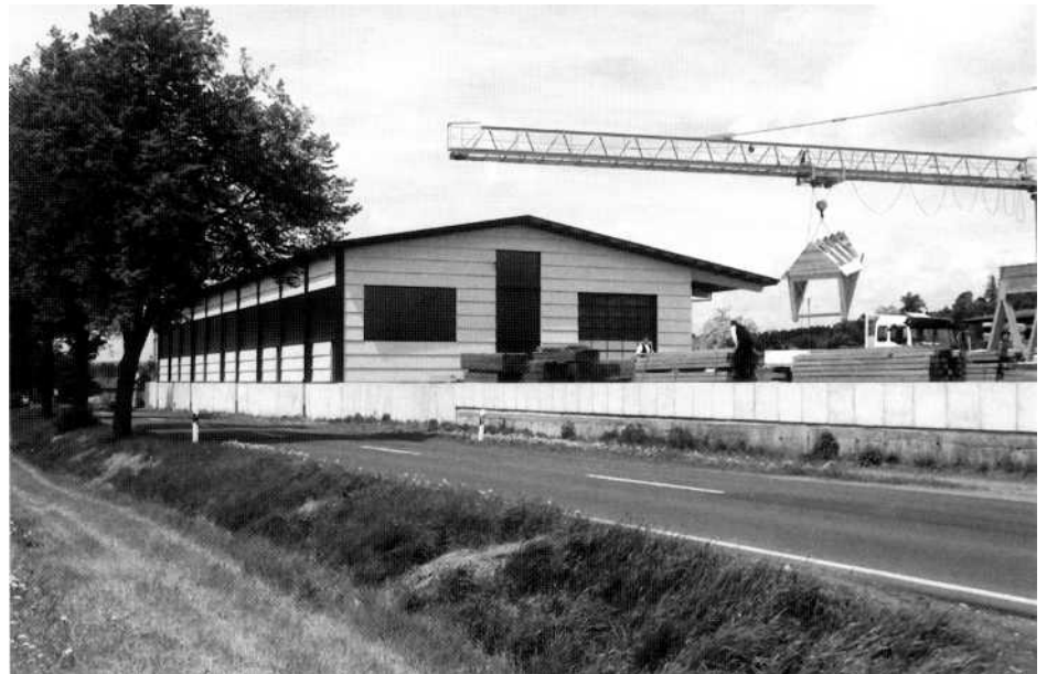
Bild 6.11 Ansicht von der Straßenseite
