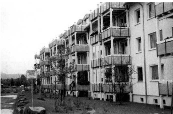
Bild 6.5 Ansicht mit Feuerwehrtür
