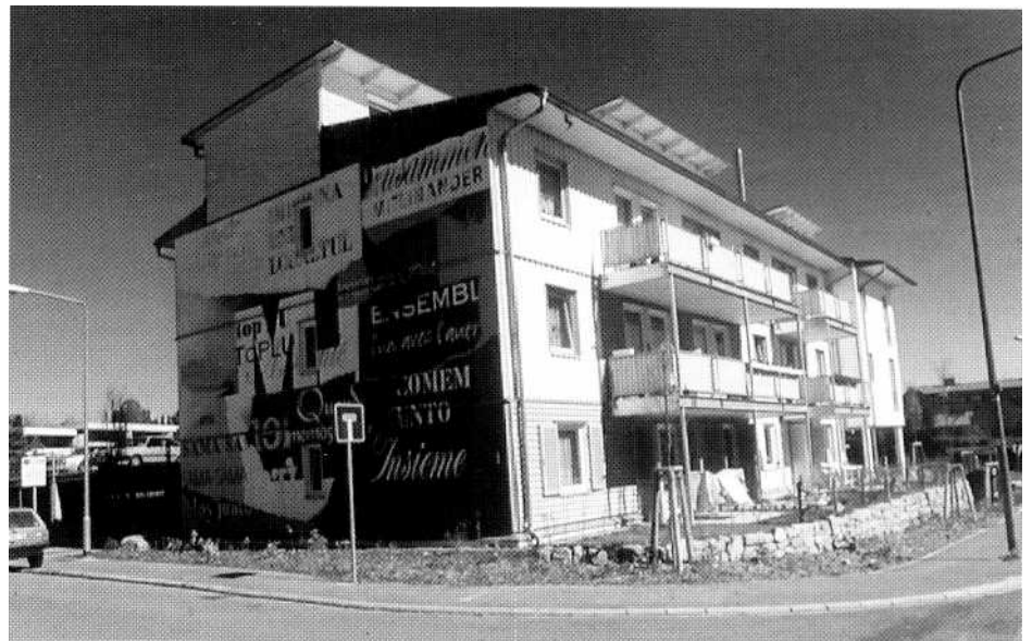
Bild 6.7 Ansicht von Südwesten
