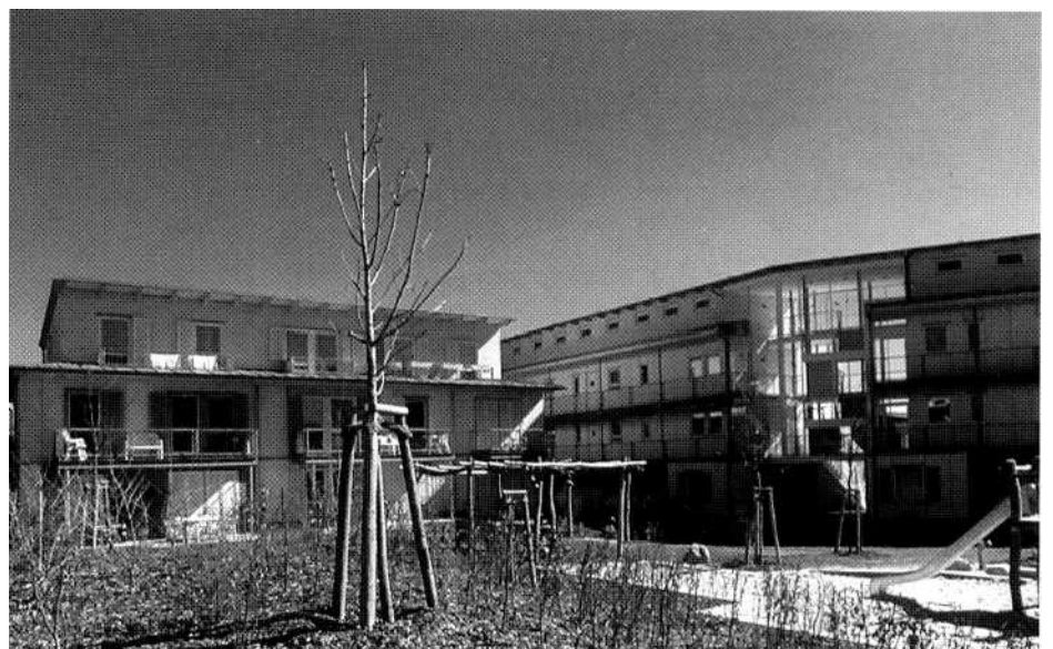
Bild 6.10 Ansicht von Norden. Erschließung über Laubengänge und verglaste Treppenträume
