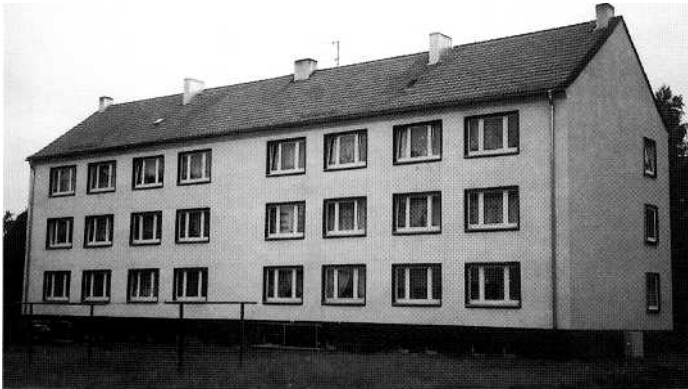
Bild 6.1 Die Wohnanlage in Ohrdruf: Vorher
