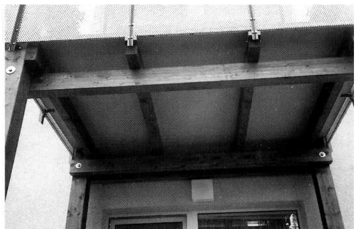
Bild 6.6 Untersicht der Konstruktion
