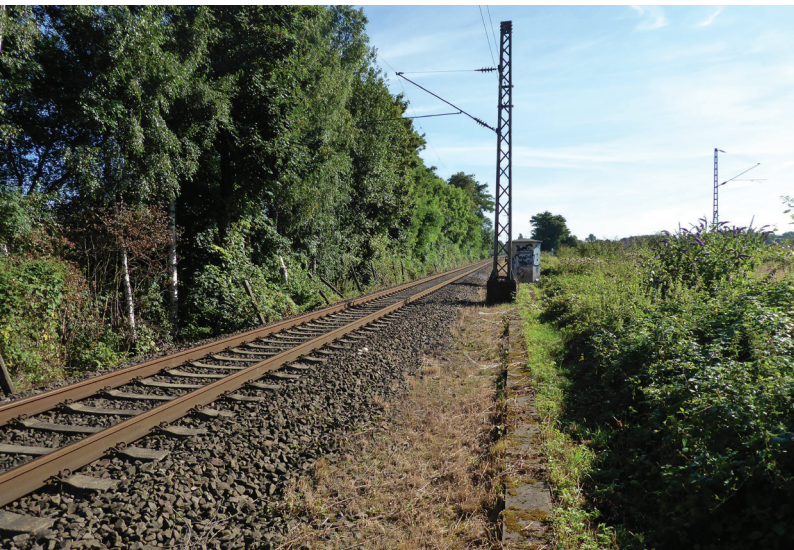
Abbildung 85: Bahnlinie im Bereich des Gleisdreiecks. Die offenen, stark besonnten Flächen und die Schotterstrukturen angrenzend zu den Brachflächen zwischen den Bahnlinien sind ideal für die Zauneidechse. Hier an der unmittelbar an die Deponie grenzenden Bahnanlage gelangen tatsächlich einzelne Nachweise (23.08.16)
