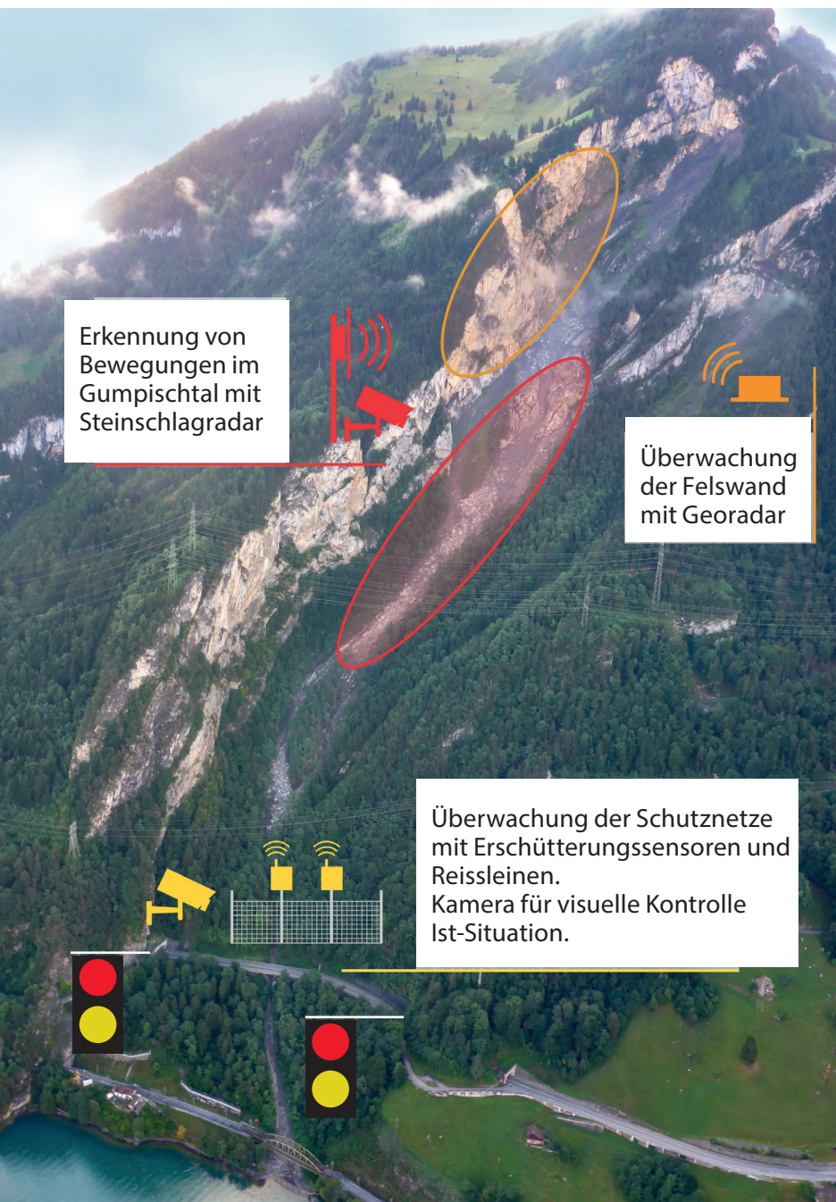
Überwachungs- und Alarmanlage im Gumpischtal.
