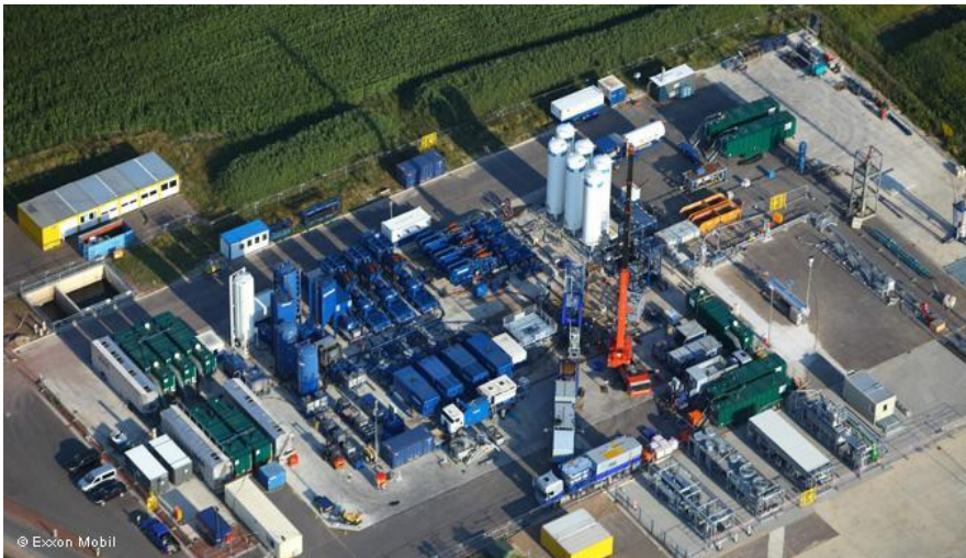
Abb. 6.10: Bohrplatz mit Neben- und Frack-Einrichtungen (Osterath 2011)
