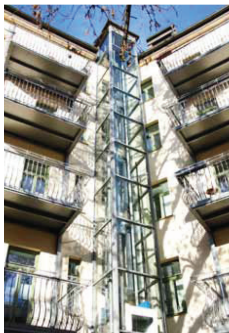
Foto: Pro-Bau Baumanagement GmbH und Vadim Kreitschmer
