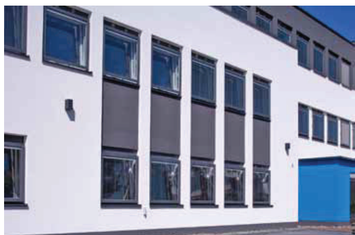
Bei dem an der Dortmunder Stadtkrone Ost entstandenen Bürogebäude wurde das Fenstersystem erstmals im großen Stil eingesetzt. Gut zu sehen sind im Bild die zur Lüftung abgestellten Außenflügel
