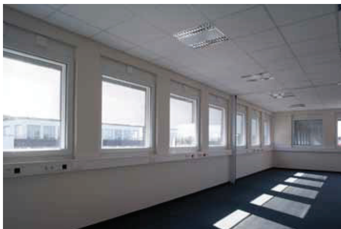
Über jedem Fenster befindet sich ein Lüftungsschacht mit integriertem Lüfter. Wenn die Frischluftzufuhr über das Öffnen der Fenster nicht möglich oder ausreichend ist, werden die Lüfter zugeschaltet
