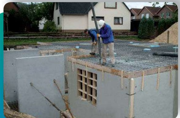
Betonieren
