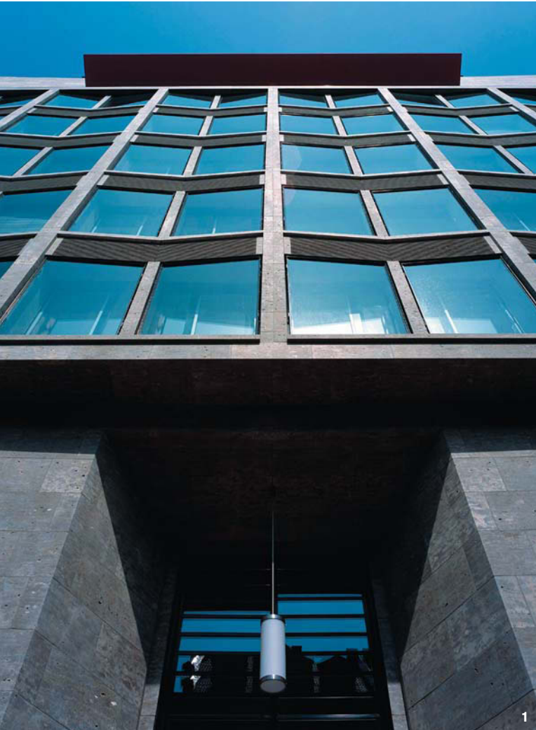
1 Bürohaus Eschersheimer Landstraße, Frankfurt am Main 2 Kunsthalle Portikus, Frankfurt am Main
