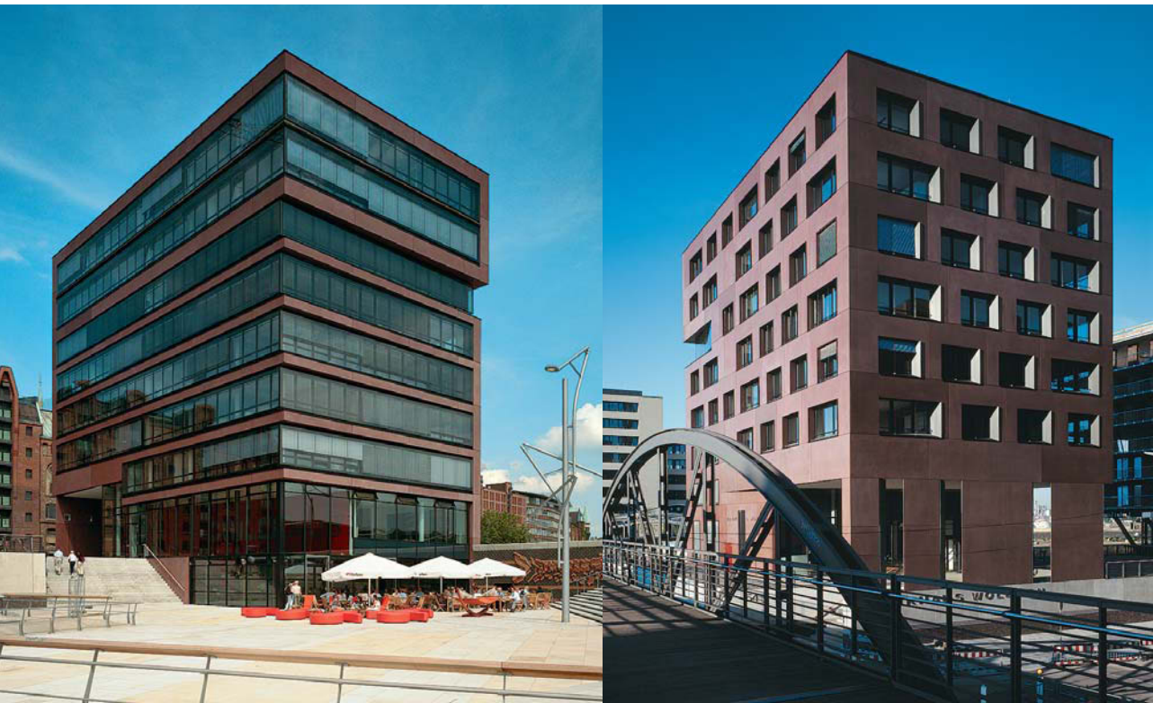
Nach Süden extrovertiert, nach Norden introvertiert – so präsentiert sich das neugeschossige Bürogebäude von Jan Störmer Partner.
