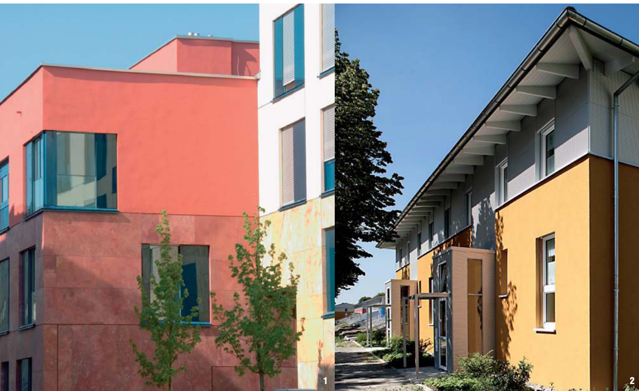
1 Wohn- und Geschäftshäuser Freilitzsch-Höfe, München 2 Ein-Liter-Haus, Ludwigshafen
