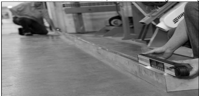
Das "PAL" Werkzeug mit der Sockelschiene ausrichten und in Richtung des gegenüberliegenden Laser-Targets richten.
