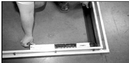
Winkel der Oberfläche abgleichen.
