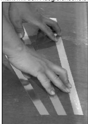
Die Ausgleichstreifen zum Füllen von Lücken unter die Sockelschiene schieben.
