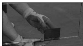
Für die meisten Standardanwendungen wird ein Kantenabstand von 6" (152 mm) empfohlen.
