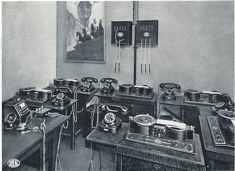
Abb. 41. Schaltzentrale des Olympischen Komitees in der Hardenbergstraße, Berlin, mit Stahltondrahtmaschinen.
