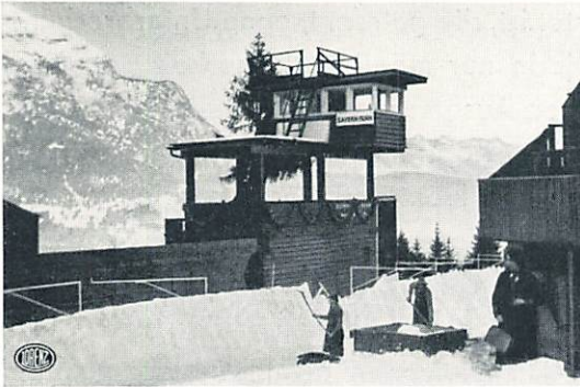
Abb. 31. Bayernturm an der Bobbahn, Garmisch-Partenkirchen.
