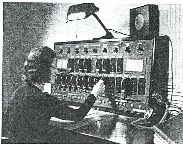
Abb. 6. Das Bedienungspult, «Herz und Gehirn» der in Abb. 5 gezeigten Grossanlage.
