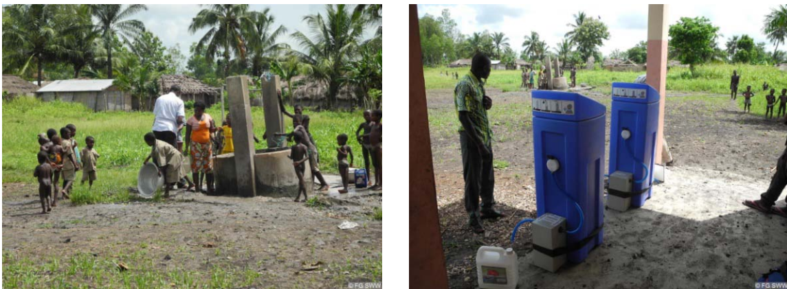
Abbildung 110: Akplenou - links: offener Schachtbrunnen, rechts: installierte Wasserrucksäcke
