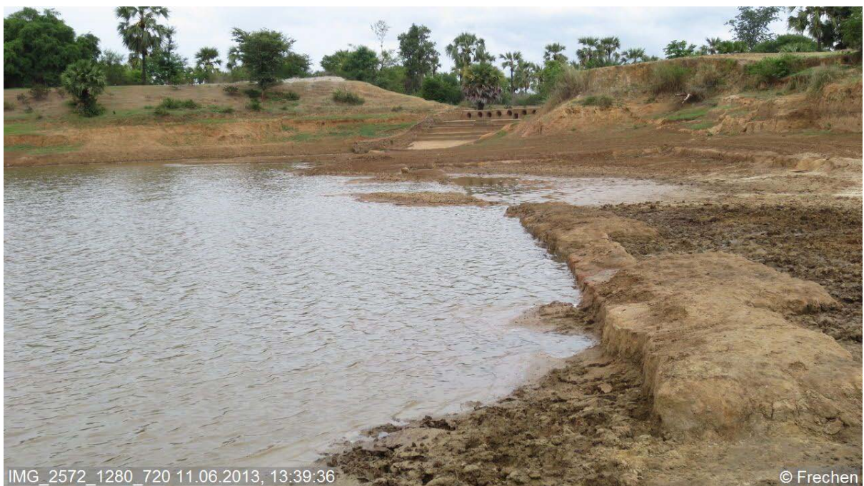
Abbildung 135: Myanmar – Wasserbecken zur Trinkwasserversorgung, teilgefüllt; im Hintergrund das Zulaufbauwerk
