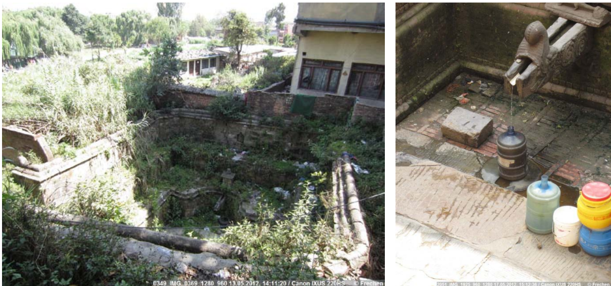
Abbildung 137: Kathmandu – Versiegte Wasserquelle (links), Wasserquelle mit geringer Schüttung (rechts)
