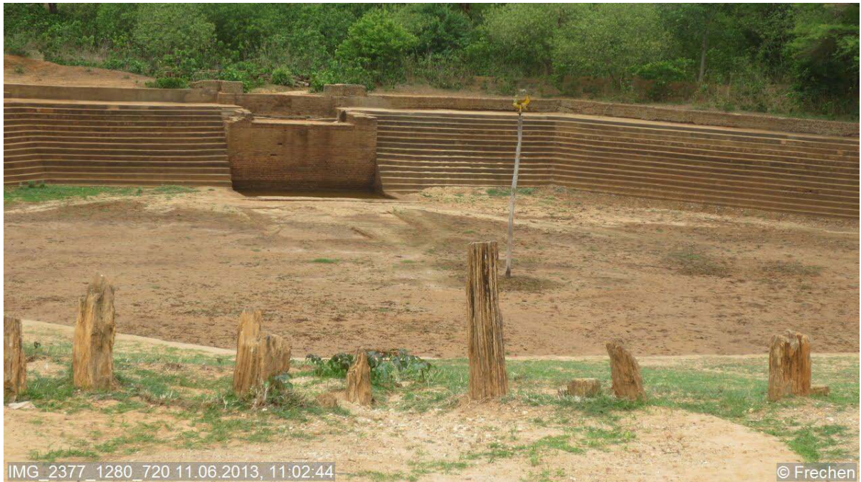
Abbildung 134: Myanmar – Wasserbecken zur Trinkwasserversorgung, leer
