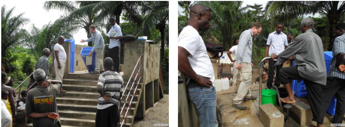
Abbildung 109: Djonougou – Vorführung und Installation
