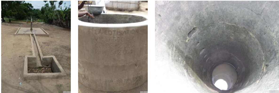
Abbildung 107: Awacou - links: unbenutzter Tiefbrunnen mit Handpumpe, mitte/rechts: offener Schachtbrunnen
