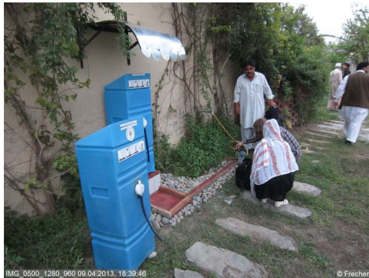
Abbildung 127: Azizabad – Wasserrucksäcke 453 (hinten) und 320 (vorne)
