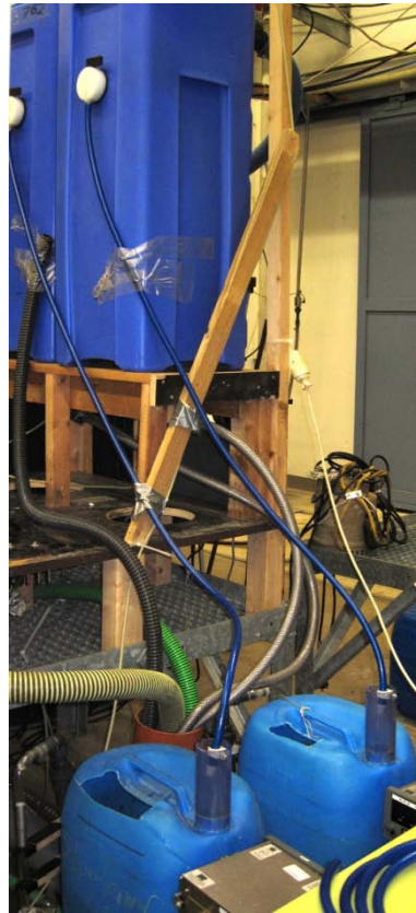
Abbildung 19: Anlagenerweiterung um eine längere Permeatsaugleitung; Höhenunterschied zwischen Kugelhahn und Ende Ablaufschlauch ca. 130 cm
