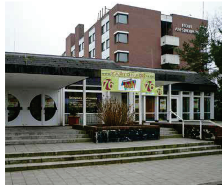
Delmeburg vor dem Abbruch
