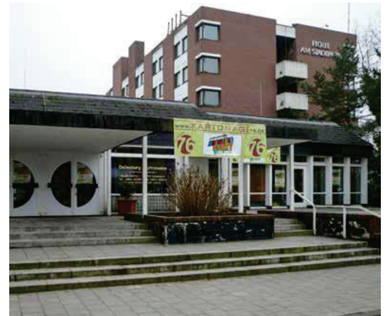
Delmeburg vor dem Abbruch
