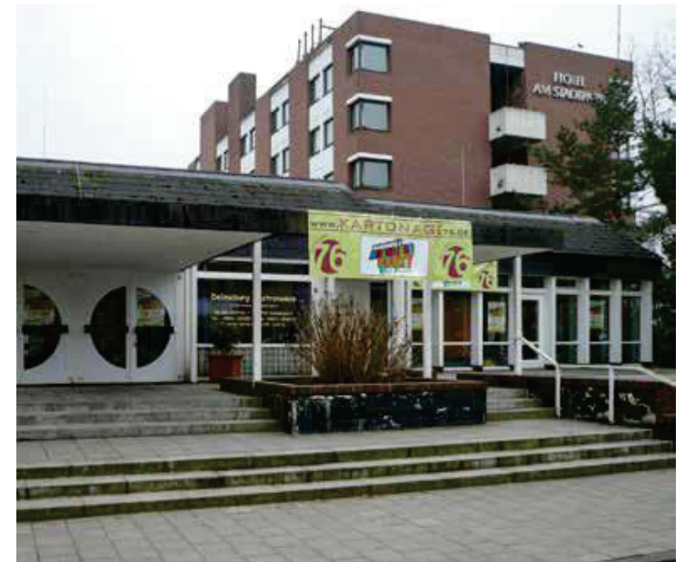
Delmeburg vor dem Abbruch
