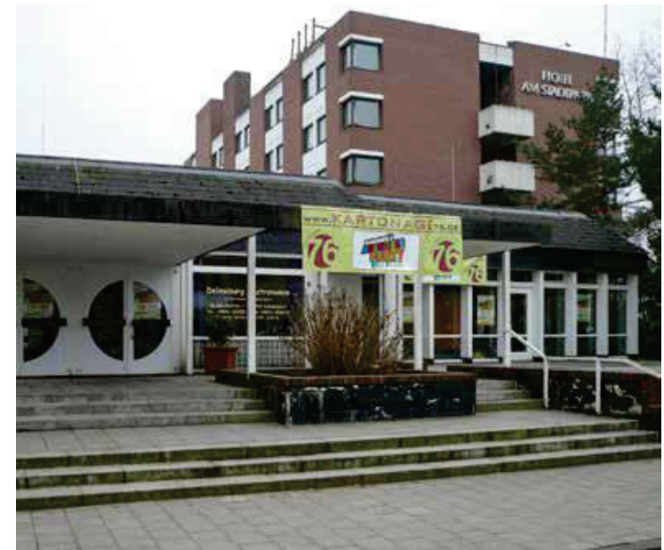
Delmeburg vor dem Abbruch
