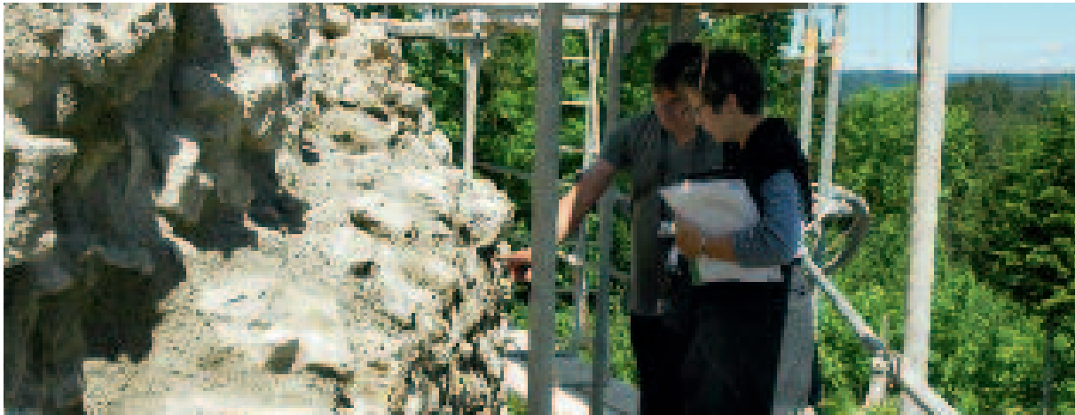
Mauersanierung auf der Schenkenburg bei Schenkzell
