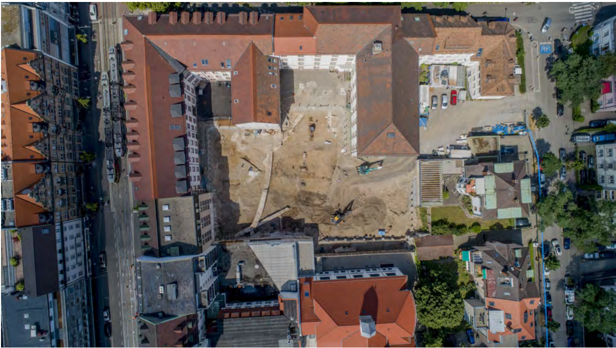
Abbildung 4: Freiburg, Kaiser-Joseph-Straße 257–259. Innenhof des Justizentrums bei der Ausgrabung. Deutlich zeichnen sich die gebogene Mauer der Barbakane und die schräg verlaufende Mauer einer frühen Bastion ab. (Drohnenaufnahme).
