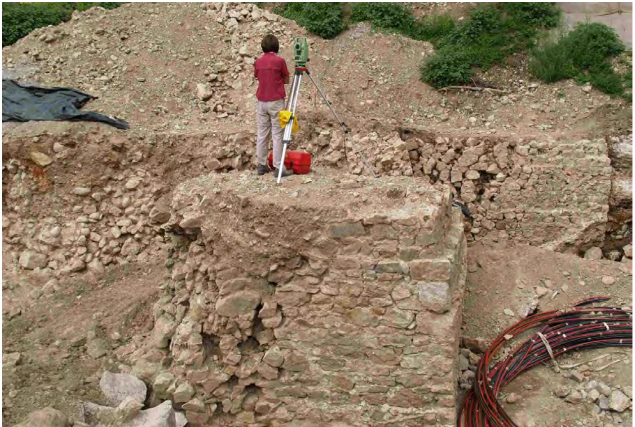
Abbildung 9: Reste der Bastion Ste. Thérèse wurden 2008 am Fahnenbergplatz freigelegt.
