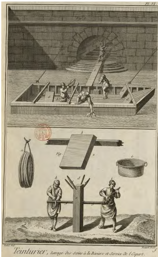
Abbildung 4 (linke Seite) und 5: Arbeitsschritte in einer Färberei nach der Enzyklopädie von Diderot und D'Alembert. In der Werkstatt (Abbildung 4) bereiten Arbeiter die Seidenbündel vor („S“), während ein Arbeiter Holzspäne für das Färben abhackt („L“). Die Seide wird anschliessend in grossen Becken gefärbt, wovon die rechten erhitzt werden („B“ mit Arbeiter „R“). Ein Arbeiter („V“) bringt die Seidenbündel zum Waschen an den Fluss, wie es auf der Abbildung 5 (oben) dargestellt wird. Zuletzt dienten Knebelstöcke dazu, das Wasser aus der Seide auszupressen (Abbildung 5, unten) und sie schliesslich zu Knoten zu verarbeiten.
