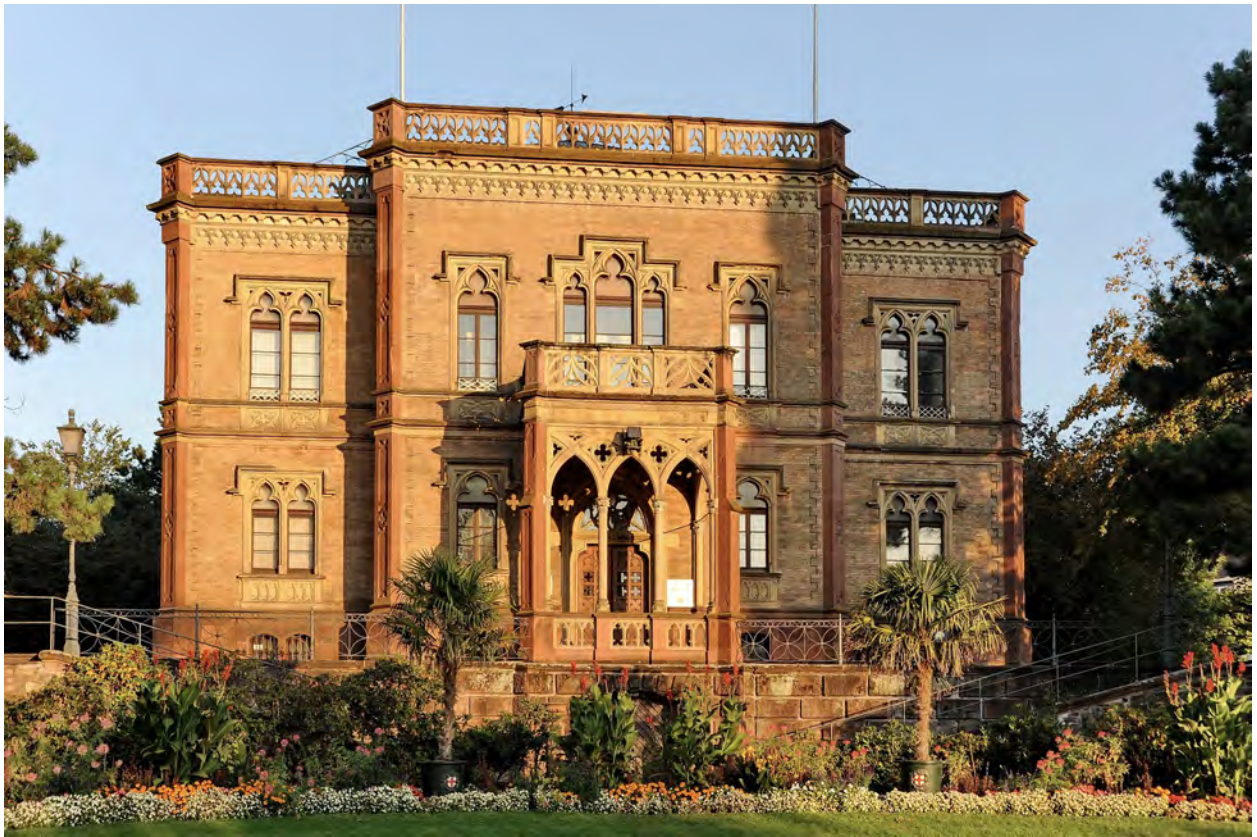
Abbildung 13: Das Colombischlösschen auf den Resten der 1744 geschleiften „Bastion St. Louis“ beherbergt seit 1983 das archäologische Museum ArCo.
