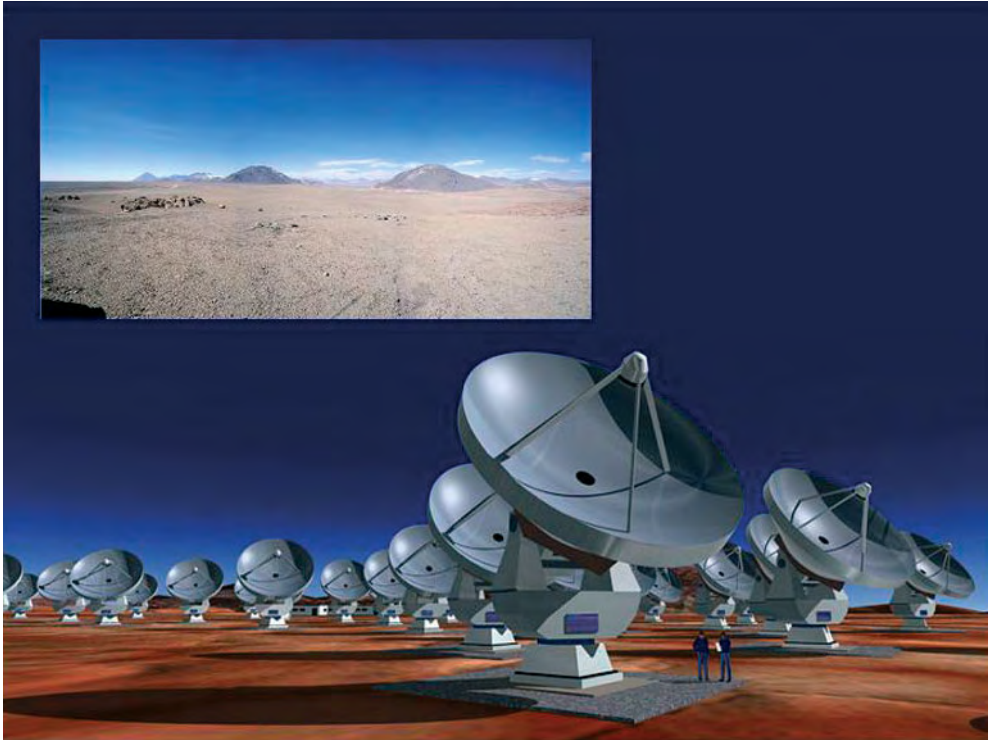
Abb. 3.4: Computerzeichnung der Interferometeranlage ALMA, die ab etwa 2010 auf dem 5000 m hohen Chajnantor-Plateau in Nordchile (Einschub oben links) mit 64 12-m-Teleskopen hochauflösende Millimeter- und Submillimeterastronomie betreiben soll. (ESO)
