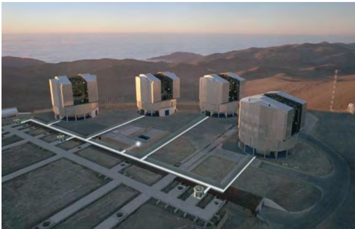
Abb. 3.1: Das Very Large Telescope der ESO auf dem Cerro Paranal in Chile. Zu sehen sind die vier, inzwischen alle in Betrieb befindlichen, 8-m-Teleskope sowie (schematisch) drei der sich in der Entwicklung befindenden 1.8-m-Hilfsteleskope für das VLTI. Ebenfalls schematisch angedeutet sind die Strahlkombinationswege für das VLTI, die in einem zentralen Labor zusammengeführt werden. (ESO)
