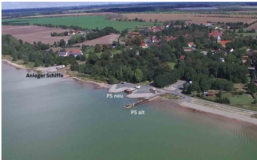
Abb. 4-5: Schlabendorfer See (RL 14/15) mit der alten und neuen Pumpstation zum RL F und Anleger des Sanierungsschiffes „Barbara“ (Foto: GIP Dresden 2015)
