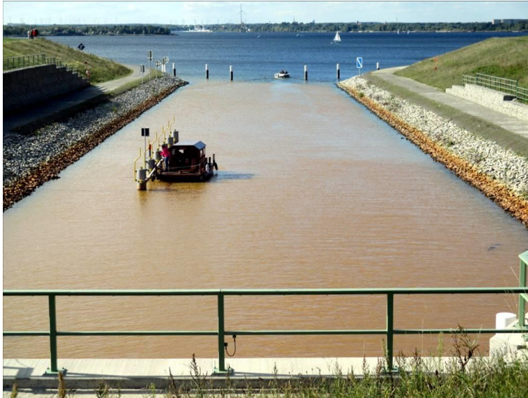
Abb. 5-6: Extremer Zustand der Verockerung im Überleiter 12 bei fehlender Durchströmung und Windstau (Foto: Norbert Herrn, LUGV)
