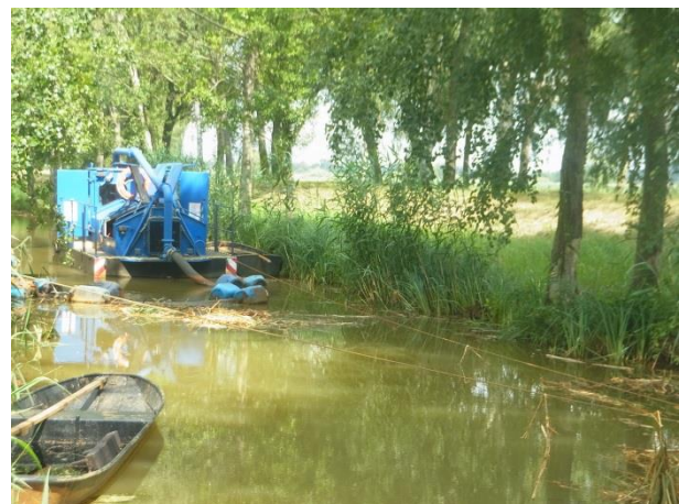
Abb. 4-6: Herstellung der Egisdorfer Teiche als zusätzlicher Absetzraum für Eisenhydroxidschlamm (links, Foto: Theiss, März 2014) und Schlammberäumung in der Wudritz (rechts, Foto: Hiekel, Juli 2014)
