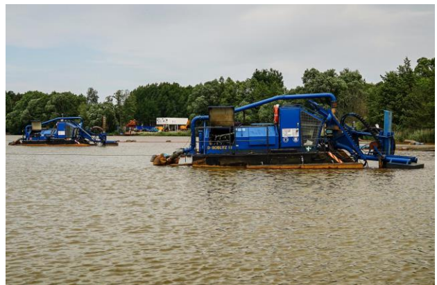
Abb. 4-18: Bekalkungsanlage an der Spree in Spremberg-Wilhelmsthal (Foto: Rauhut, August 2015) und Saugpülbagger bei der Entschlammung der Vorsperre Bühlow (Foto: Uhlig Mai 2015)
