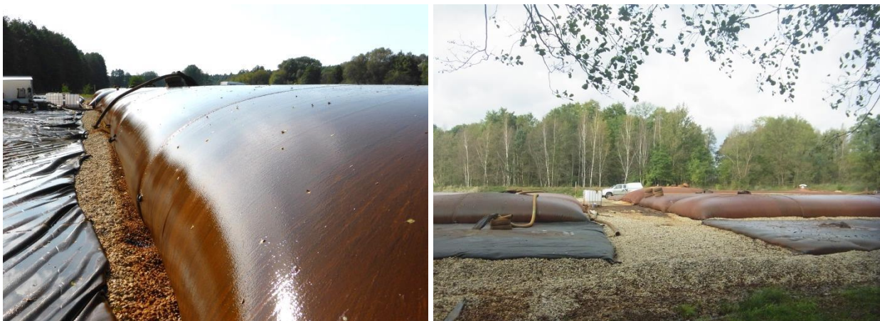
Abb. 4-11: Geotubes zur Schlammbehandlung bei Beräumung des Vetschauer und des Neuen Vetschauer Mühlenfließes (Foto: Hiekel, September 2014)
