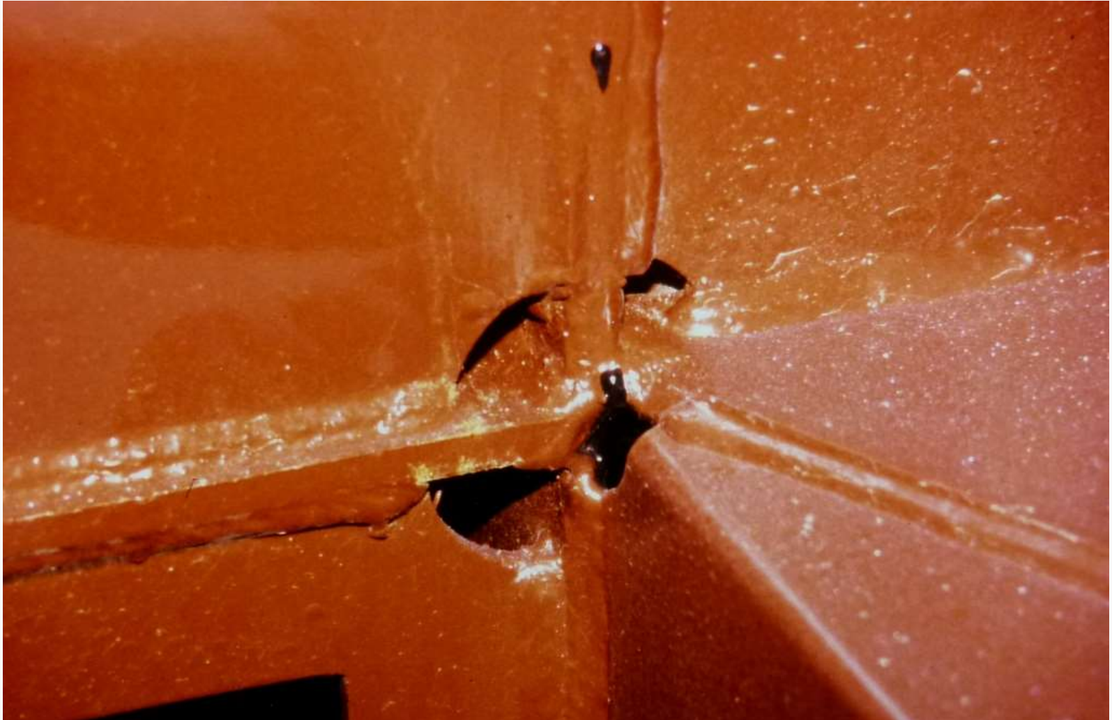
Falsch! – Übertriebene Aussparung an Ecken
