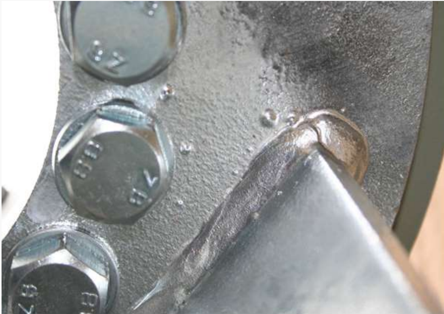
Innenseite geschweißt – höchstbeanspruchte Stirnseiten umschweißt
