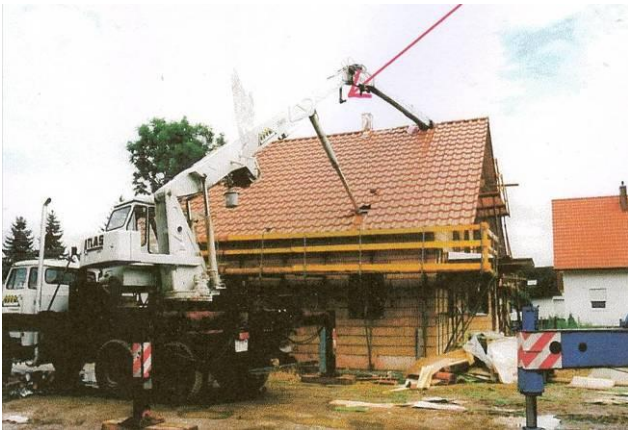
Bild 34: auf Hausdach gestützter Ausleger
