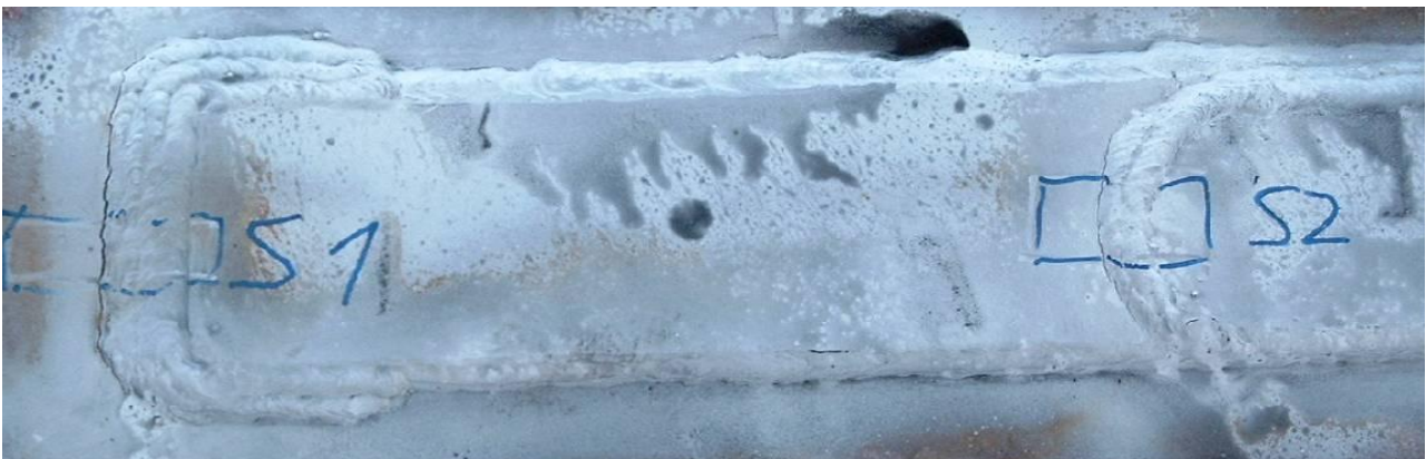
Bild 23: Anrisse an Quernähten der aufgeschweißten Verstärkungsblechen
