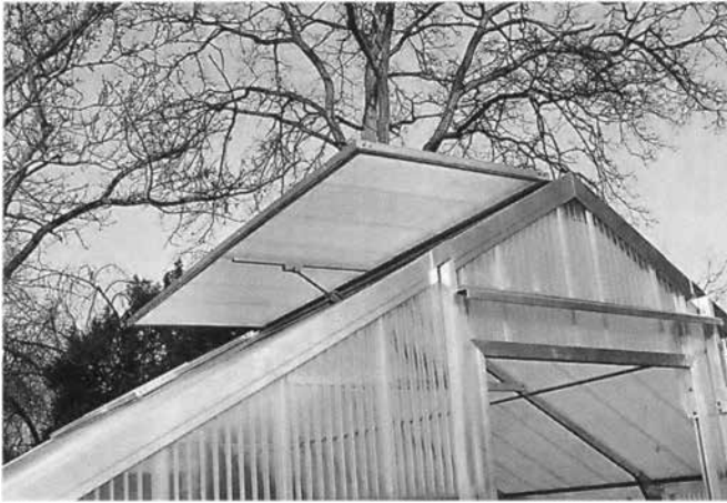
Großes Giebelfenster mit automatischem Fensterheber
