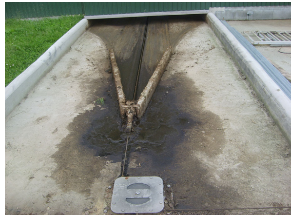
Abb. 2: Faltschieber mit Seilzug und Führungsschiene (links: STEINER und KECK, 2000; rechts: PELZER, 2005)
