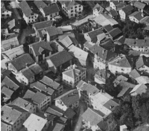
Luftaufnahme frühere Situation Dorfplatz
