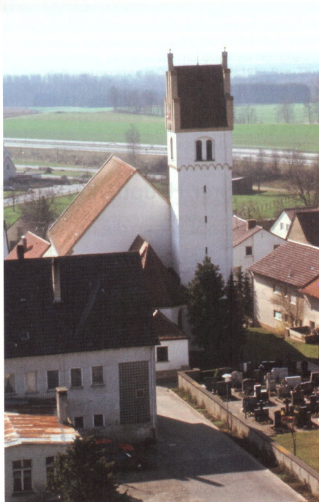
Das alte Volksschulgebäude in Baltringen im Jahr 1970 mit dem Schulraum der Unterklasse im EG und einem Zimmer für deren Lehrkraft. Im OG befand sich die Wohnung des Schulleiters; im Anbau (Vordergrund) der Unterrichtsraum für die Oberklasse. 3
