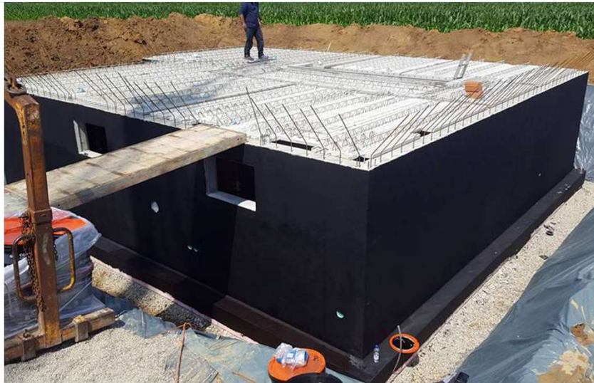
Abdichtung Bodenplatte/Kellerwände (Schwarze oder weiße Wanne)
