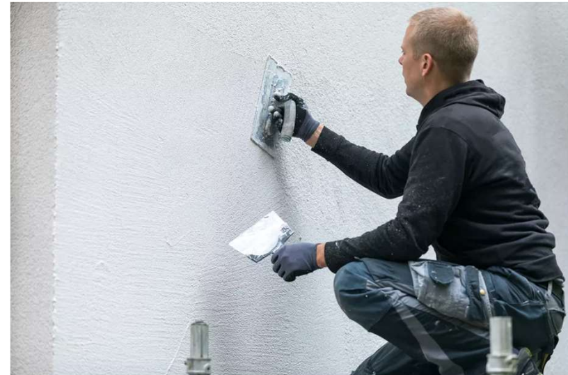
Schutz durch wasserdichten (Außen-)Putz
