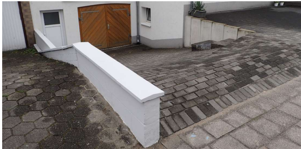
Aufpflasterung der Einfahrt Quelle: SEBD
