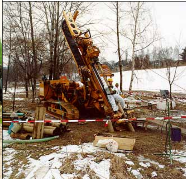
Untersuchungsgesenk, Veratzbohrung, Verfüllarbeiten
