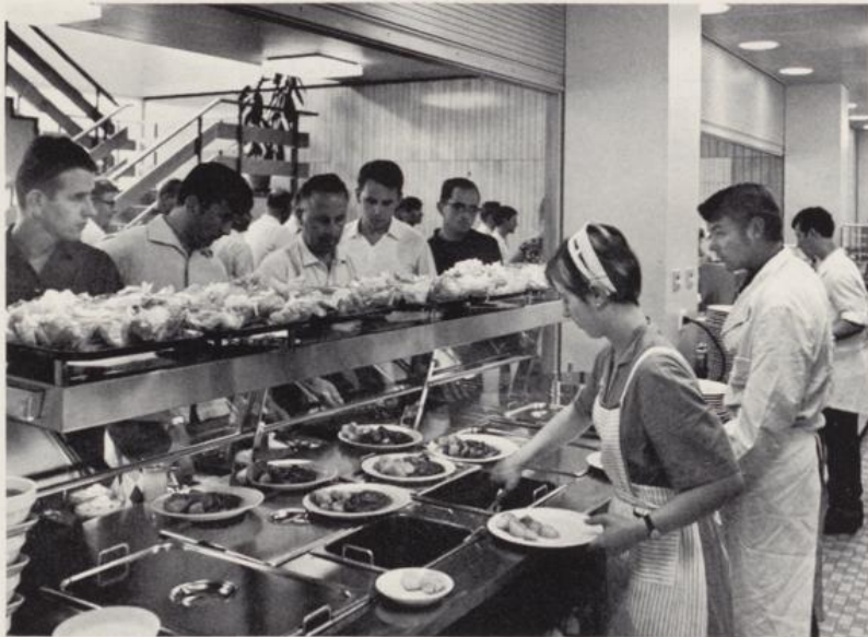
Oben: Blick vom Office auf die Speiseausgabe für Angestellte in der Eingangshalle.
