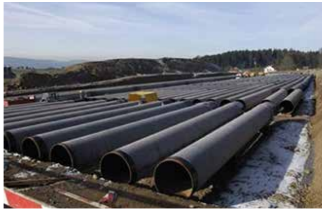
Abbildung 7: Röhrenspeicher in Gutenswil in der Schweiz (Grafik: Energie 360°)
