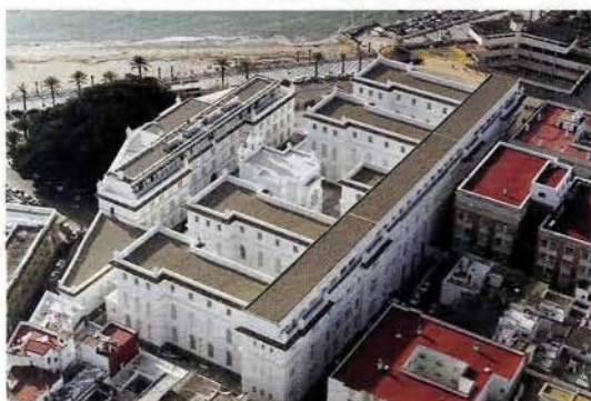
Früheres Mora-Krankenhaus nach seiner Eingliederung in die Universität Cádiz
